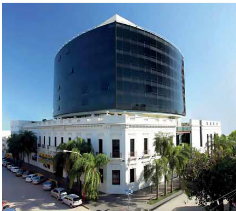
Edificio del hotel Savoy, luego Hospital para la Madre y el Niño. Actualmente, Casinos Gala y Hotel. Fuente: autora
