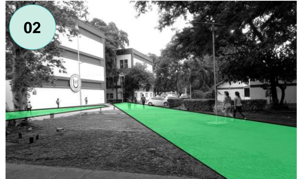
Referencia 02 : Circuito peatonal sin sendero, con cruces peatonales peligrosos en sectores de alto tránsito vehicular.
