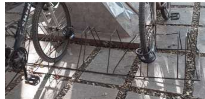
FOTO : Bicicletero de referencia en mal estado. Fuente: relevamiento físico.
