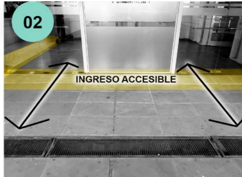
Ref. 2: Acceso secundario a Fac. de Arq.: Cuenta con rampas adecuadas para un ingreso seguro.
