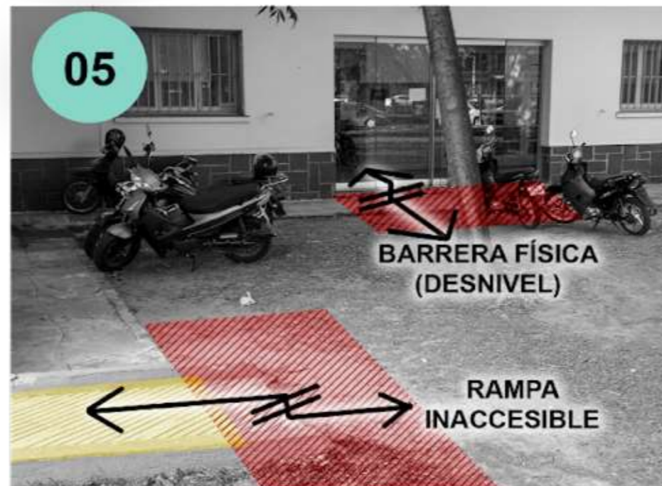
Ref. 5: Acceso secundario a extensión universitaria: Cuenta con una rampa que desemboca sobre terreno natural, que se encuentra más bajo que la misma.
