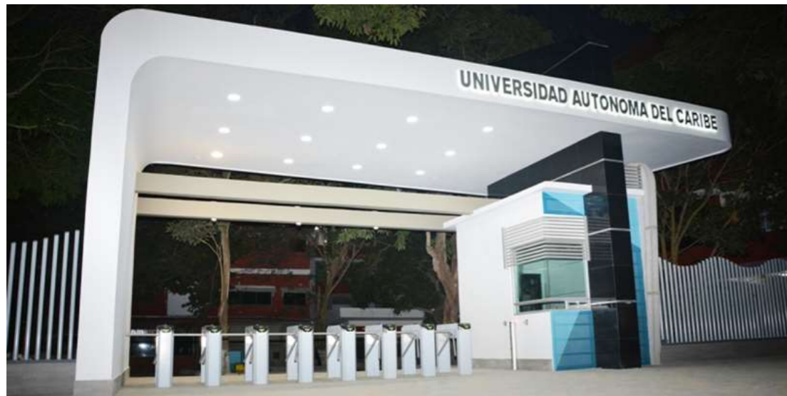
Figura 9 C1- Pórtico de ingreso a la universidad con incorporación de sistemas de control de accesos y egresos.
