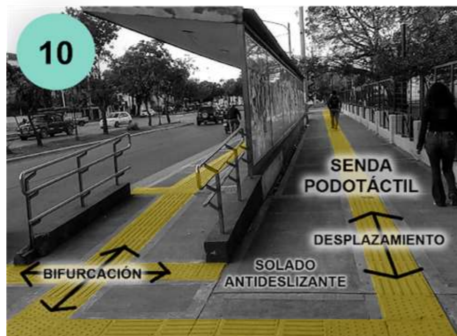
Ref. 08: Vereda sobre Av Las Heras y parada de Colectivo: Cuenta con una rampa con pendiente adecuada para subir al colectivo y está correctamente señalizado.
