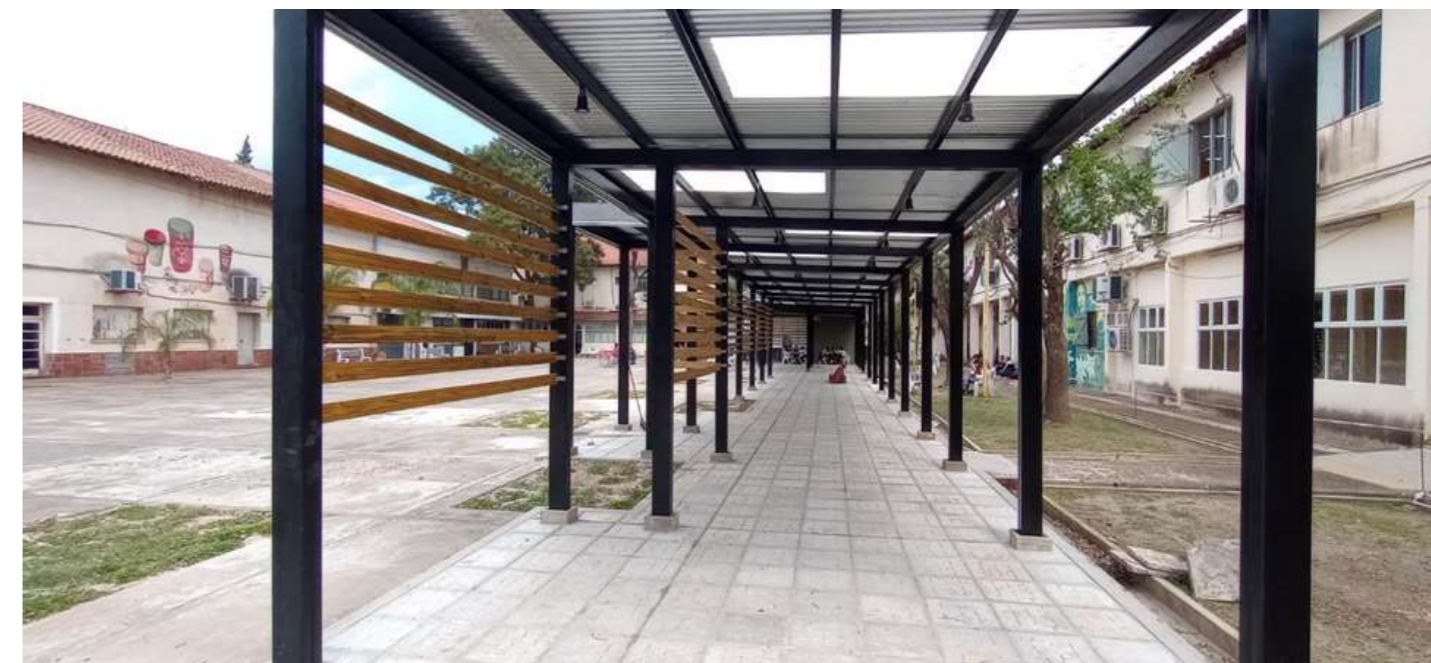
Figura 71: Estructura semicubierto perteneciente al Patio Central de Humanidades, espacio de integración y encuentro.
