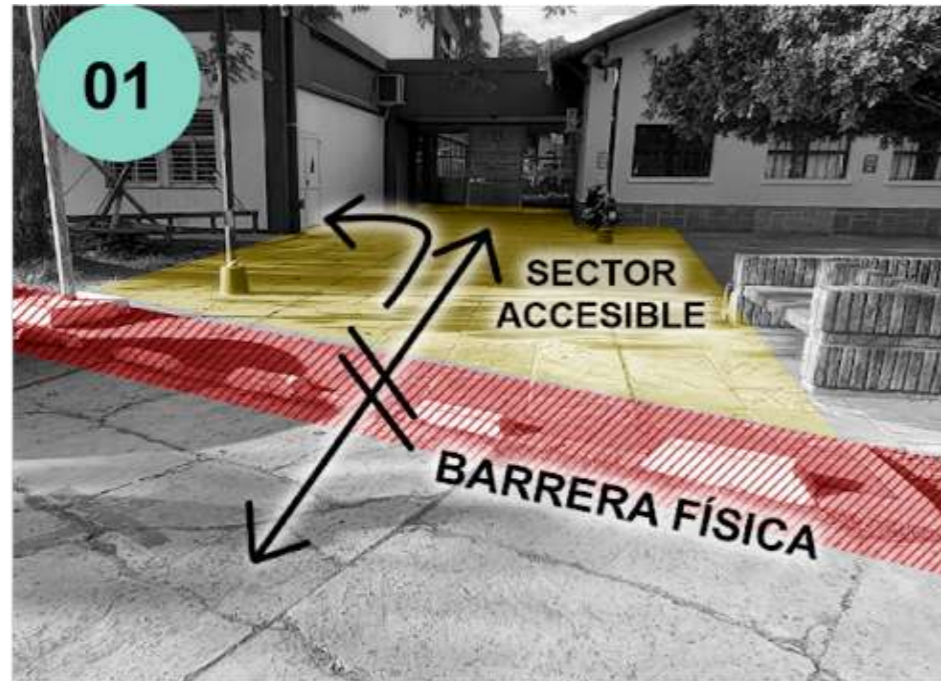
Ref. 1: Acceso secundario a Fac. de Arq.: Cuenta con barrera física desde el circuito vehicular que dificulta el acceso a personas con movilidad reducida
