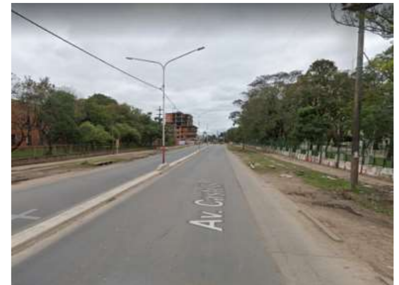
Tramo de la Av. Castelli que limita con el Campus con su única vía de doble circulación. .Fuente: Elaboración propia
