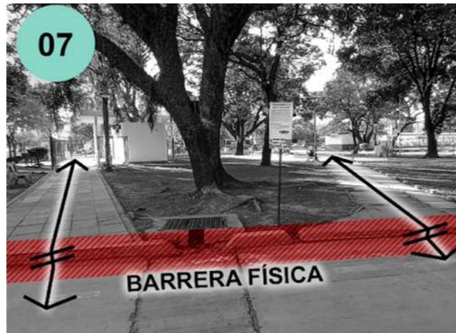
Ref. 07: Ingreso desde Av. Las Heras: Dos senderos peatonales sobreelevados que desembocan en una calle interna sin contar con rampa.
