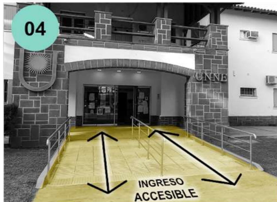
Ref. 4: Acceso a Extensión universitaria y auditorio: Cuenta con una rampa de doble carril y sendero podotáctil, con pasamanos.
