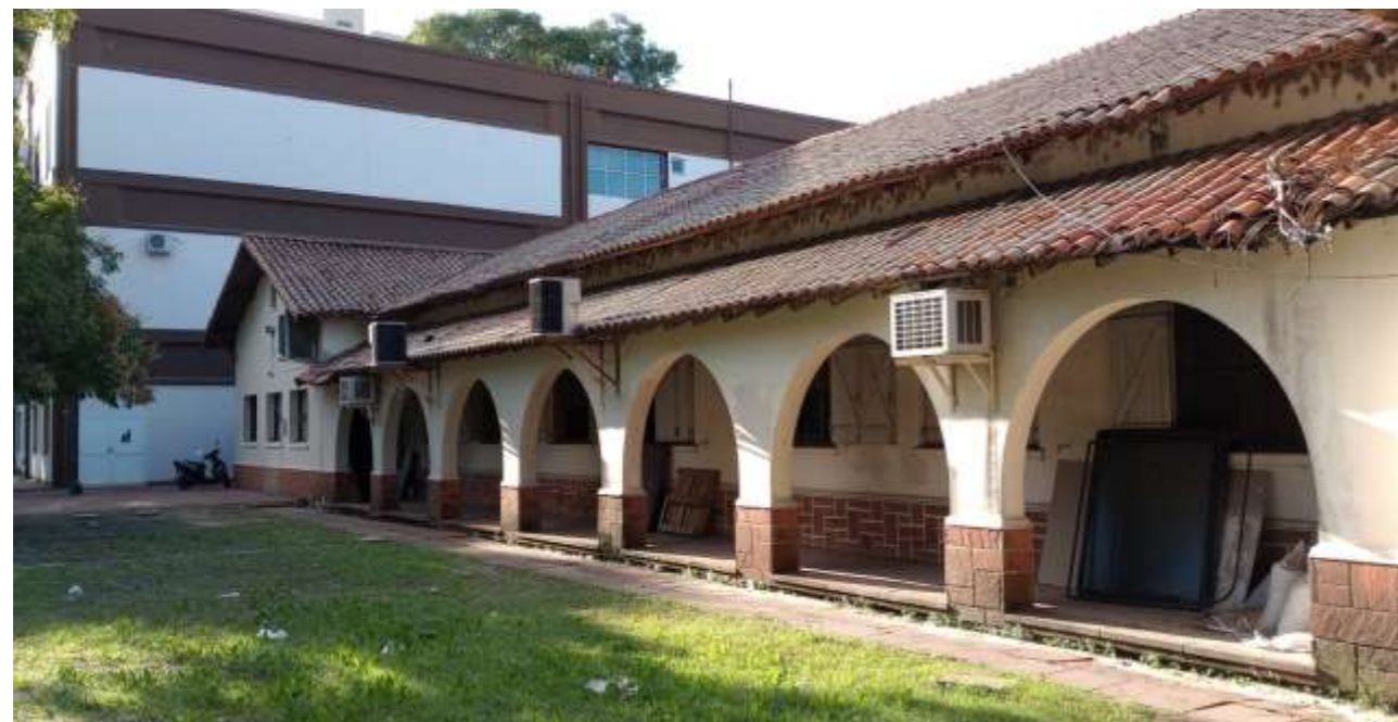
Figura 77: Galerías Corridas Exteriores de la Facultad de Arquitectura frente a la Avenida Castelli en buen estado y conservado.
