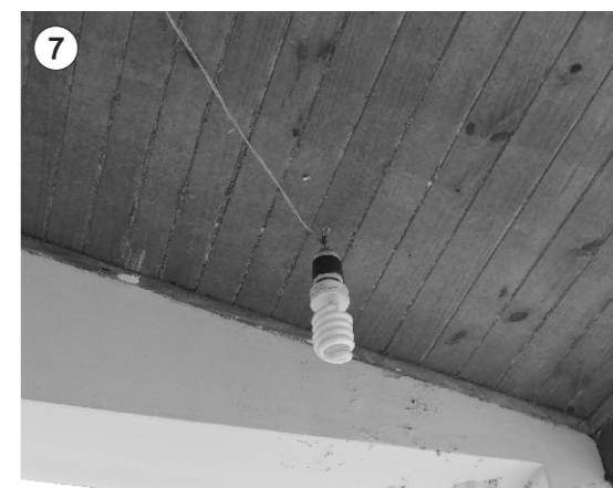
Instalación de luminaria precaria.
