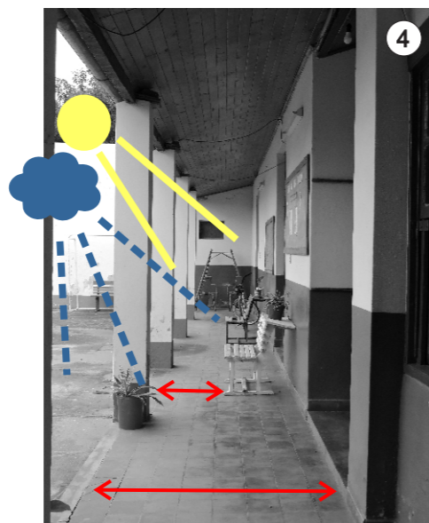
Pasillo - hall distribuidor
