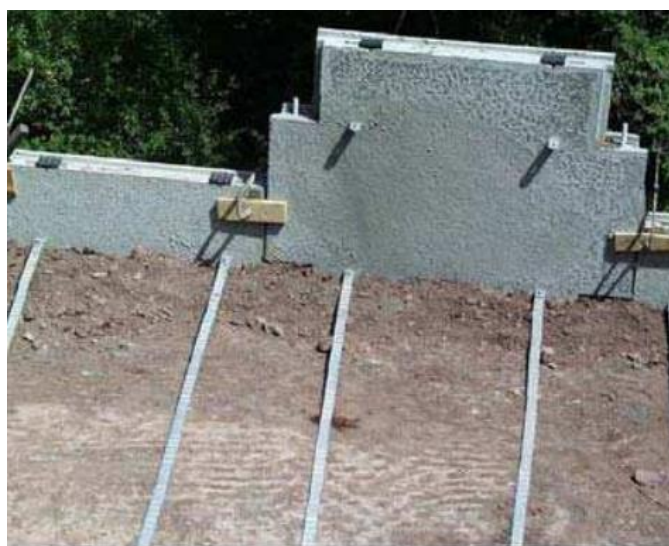
Figura 33. Detalle de conexión entre escamas de hormigón y flejes de acero (fuente: Apunte de estructuras de contención, Universidad Nacional de la Plata).
