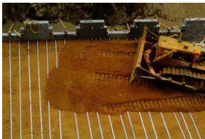
Figura 34. Detalle del material del relleno utilizado (fuente: Apunte de estructuras de contención, Universidad Nacional de la Plata).
