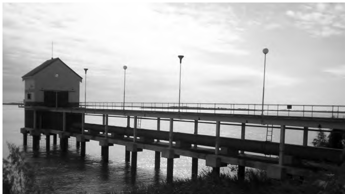
Imag 21: Toma de cámara. Está compuesta por electrobombas que extraen el agua cruda (no apta para el consumo) y que la impulsan a través de cañerías hasta la planta para su posterior tratamiento.
