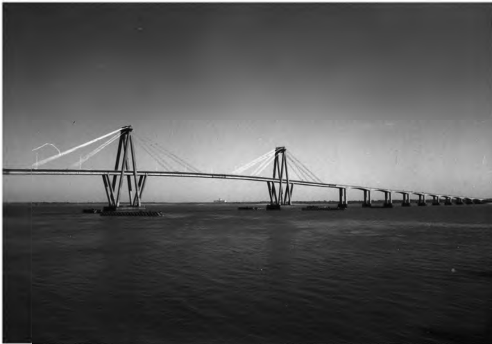
Imag 11: Puente “General Belgrano”. Une Corrientes con Chaco, fue construido en 1973.
