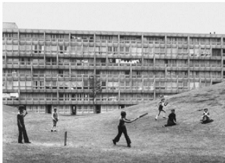
Robin Hood Gardens en Poplar (Londres) De Alison and Peter Smithson Año construcción: 1960-1972.
