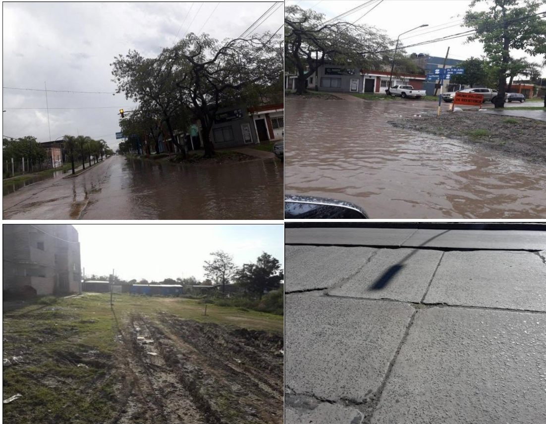
Fig. 25: Zonas bajas y calzada en mal estado (fuente: Elaboración propia).
