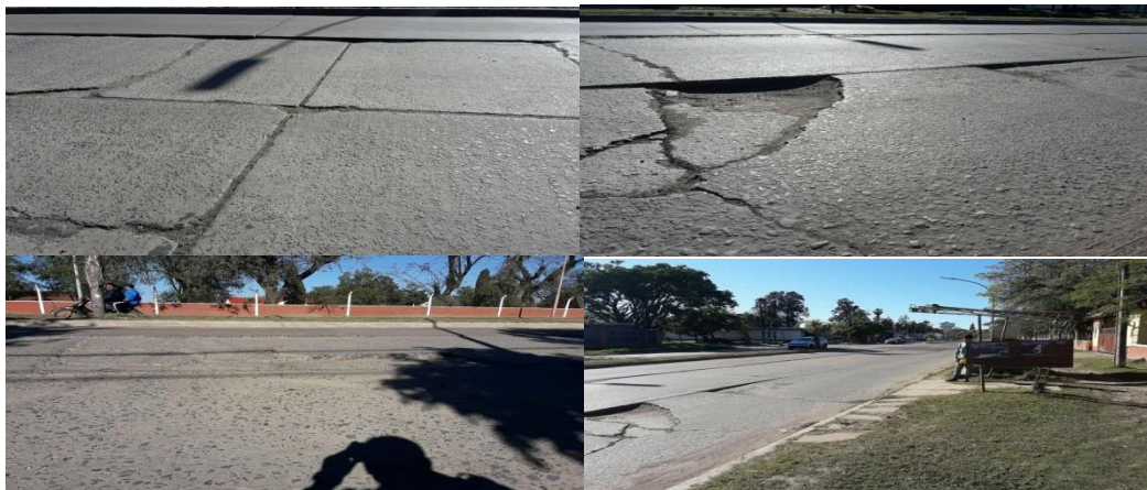
Imagen 1: Baches sobre av. 9 de Julio (fuente: elaboración propia).
