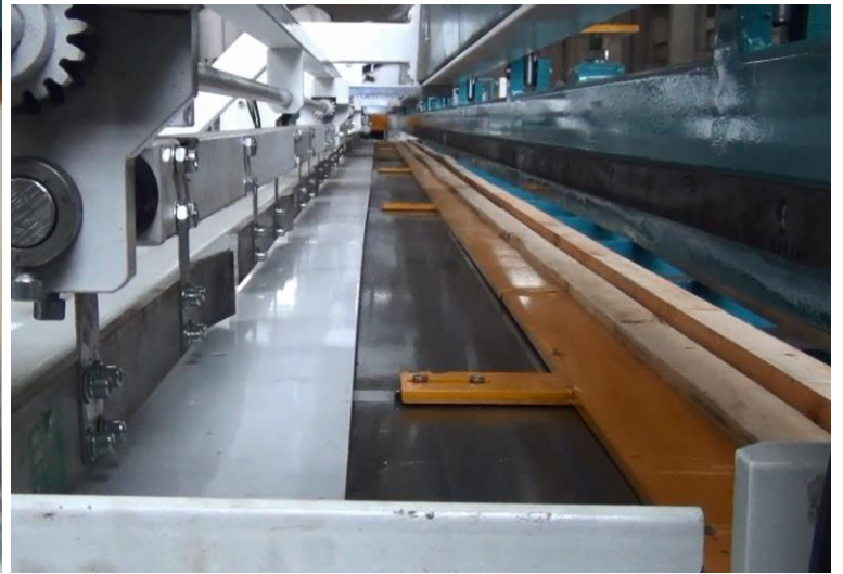
Desplazamiento automático de carga a prensa.
