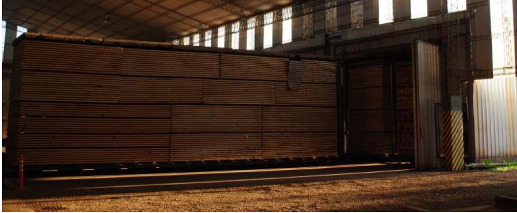
Figura 27. Ingreso al horno de secado. (Fuente: Victoria maderas, 2012)
