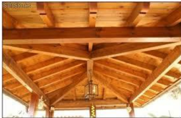
Figura 17. Estructura de techo. (Fuente: http://vettagrupo.com )
