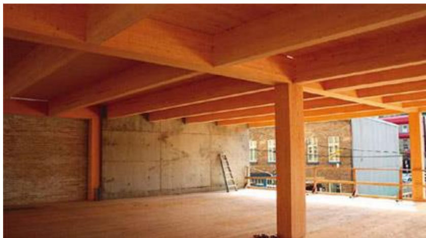
Figura 18. Entrepiso de madera. (Fuente: http://www.cadamda.org.ar )
