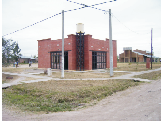
F5- Puesto sanitario Foto de FOULKES MD/2006
