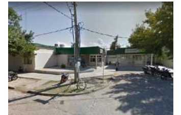
Acceso de emergencias a área de maternidad sobre Calle José R. Vidal
