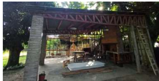
Fig. 10: Prototipo ejecutado a escala real, estado actual de la obra gruesa.
