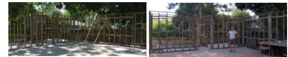
Fig. 8: Montaje de los paneles verticales (izq.) sobre el basamento. Los conectores verticales ejecutados In-Situ (der.). Escala humana, Arq. G. J. Jacobo, delante del sector "dormitorio-baño" (der.). Fuente: fotos propias de los autores, verano 2021-2022.
