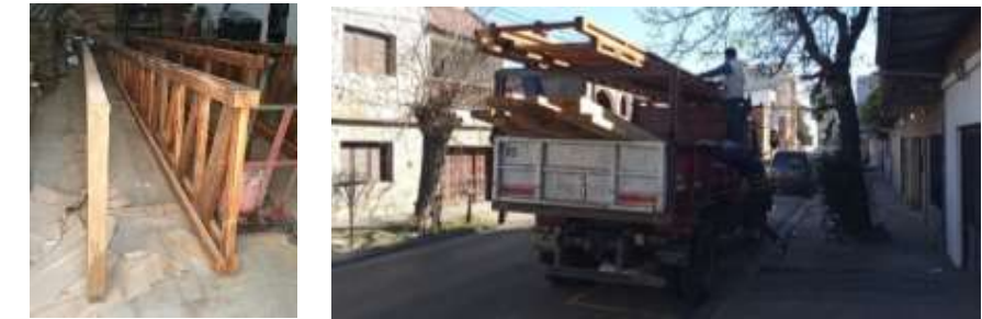
Fig. 7: Producción en taller de los paneles prefabricados (izq.) y transporte al sitio de ejecución (der.). Fuente: fotos propias de los autores, verano 2021-2022.
