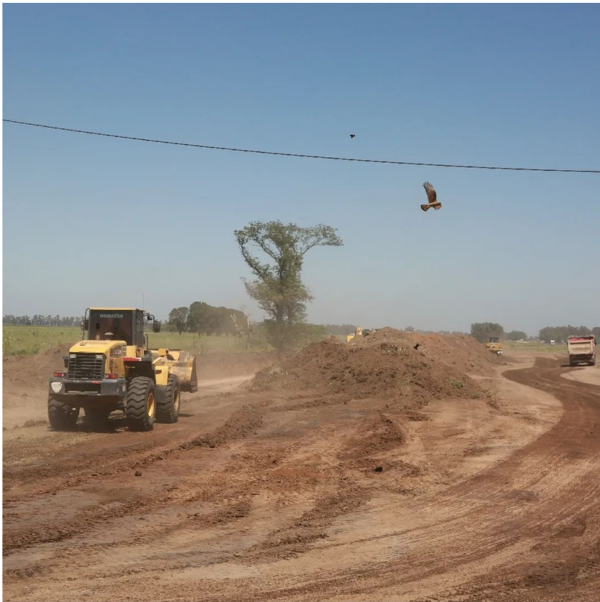
Figura 9.5.3. - Acopio de suelo para terraplenes - Fuente: Instagram Vialidad Nacional.
