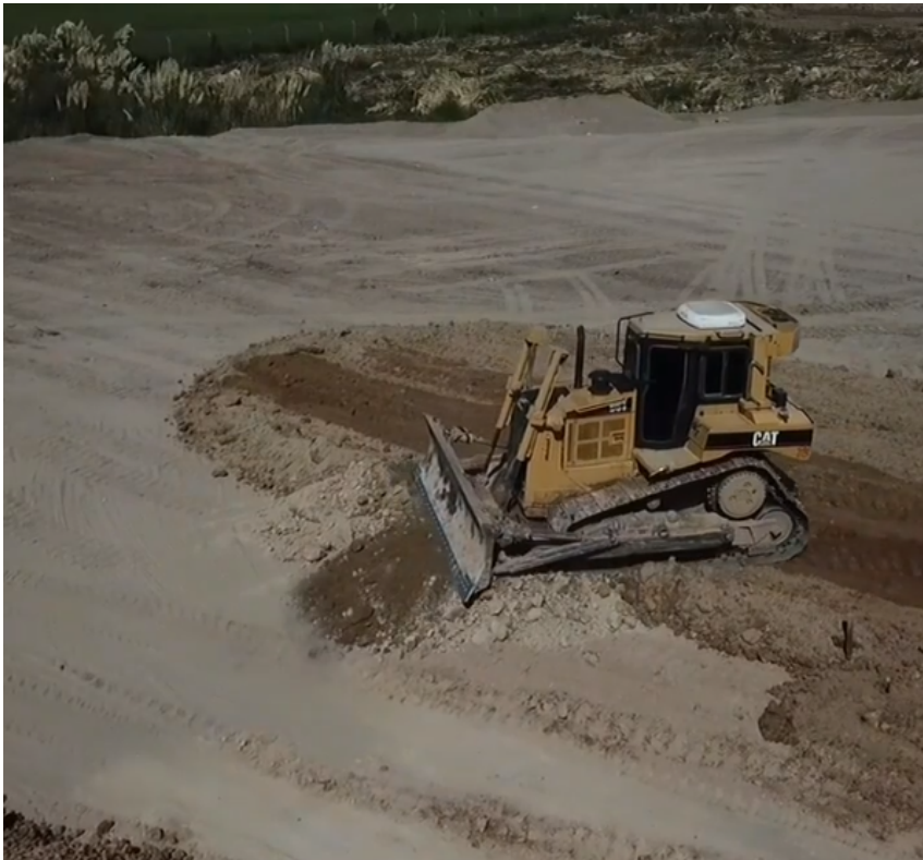
Figura 9.5.2. - Acopio de suelo para terraplenes - Fuente: Instagram Vialidad Nacional.
