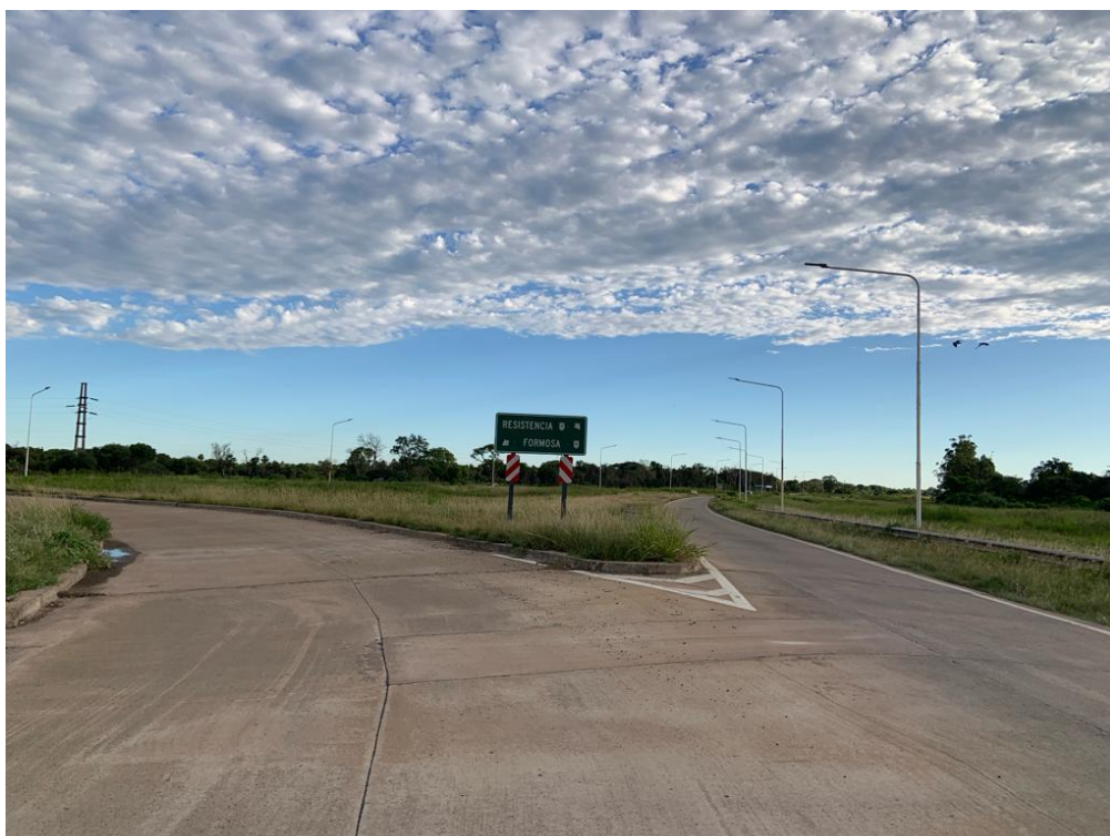
Figura 1.3.4. - Entrada a rotonda por RP 90 - Fuente: Propia.
