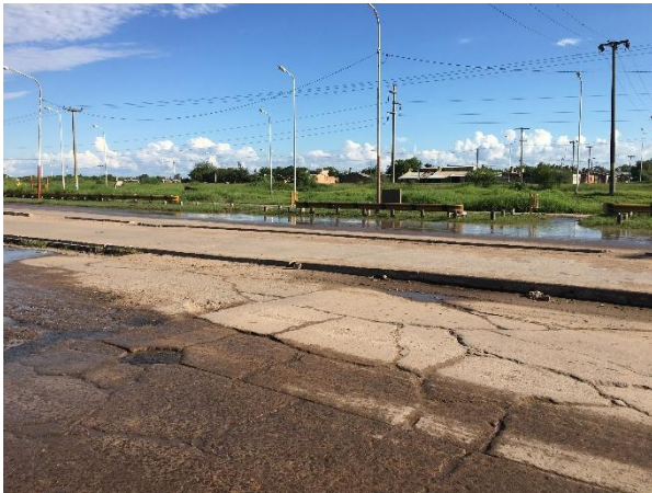
Figuras 13 y 14: Patologías en la calzada (fuente: elaboración propia)
