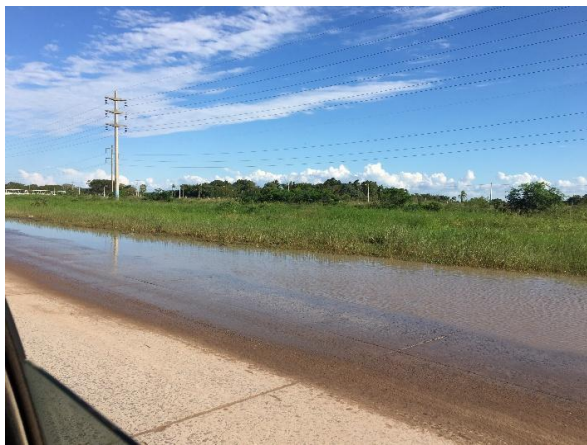
Figuras 16 y 17: Acumulación de agua en la calzada (fuente: elaboración propia)
