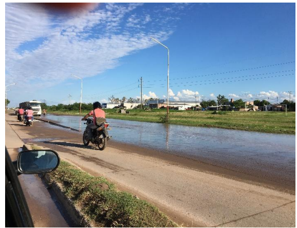
Figuras 16 y 17: Acumulación de agua en la calzada (fuente: elaboración propia)
