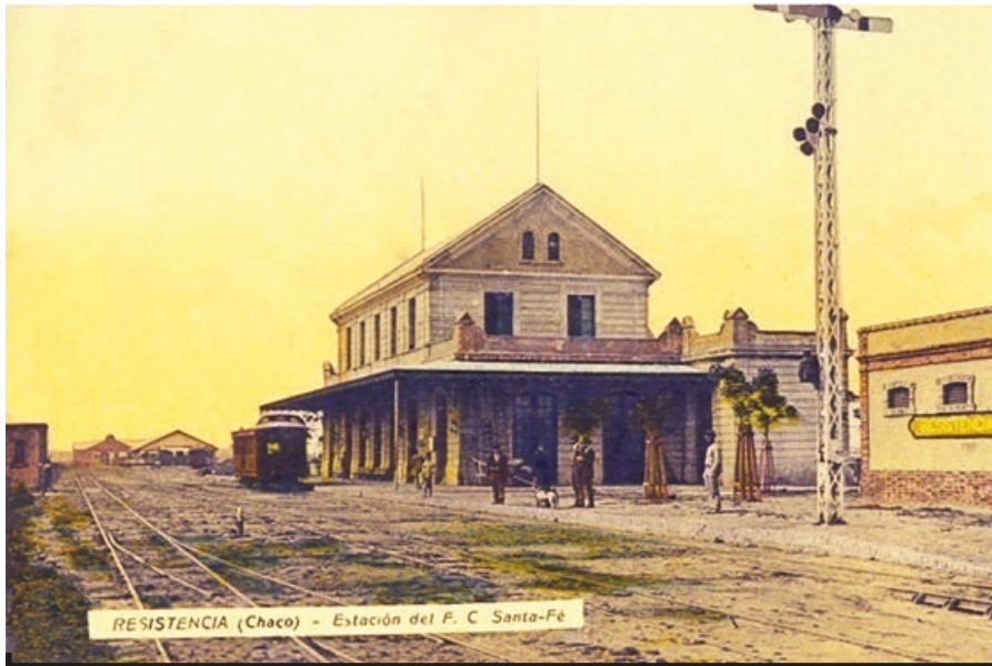
Figura 30. Estación del ferrocarril Santa Fe. http://resistenciarquitectura.blogspot.com
