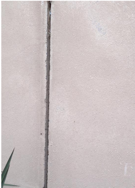
Figura 13. Junta de separación de edificios. Barrio Vialidad de Ingeniero White.
