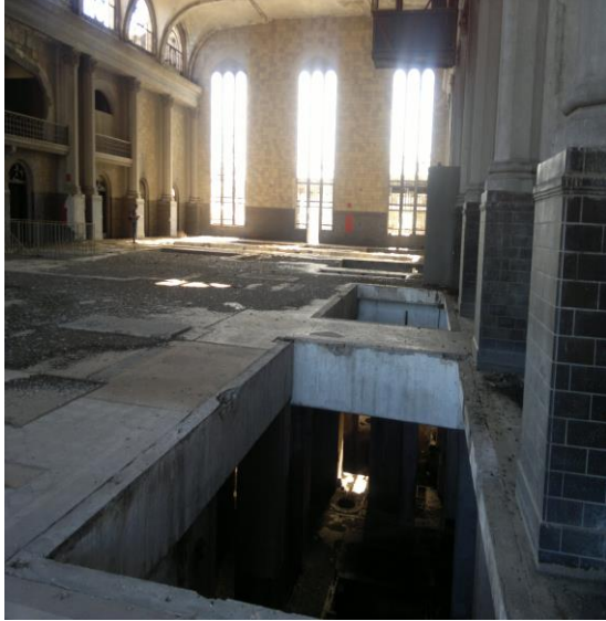
Figura 16. Interior de la Ex Usina.
