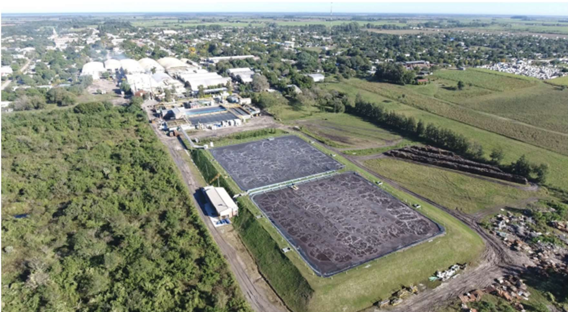
Fig. 2: Curtiembre ARLEI S.A. Planta Las Toscas, Planta de Tratamiento de Efluentes. Vista Este.
