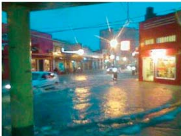
Figura 4. Inundación pluvial - Calle Yrigoyen esquina Uruguay ciudad de Corrientes. (Fuente: propia 2011)
