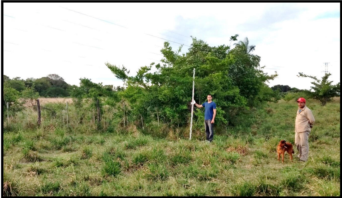
Figura 11: Fotografía durante una jornada de nivelación (Fuente: Elaboración propia)
