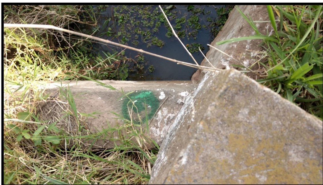
Figura 10: Fotografía punto fijo IGN sobre alcantarilla sobre R.P. Nº5 (Fuente: Elaboración propia)
