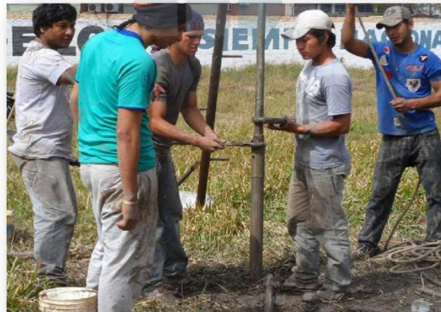
Ensayo SPT - Tareas de extraccion de muestras
