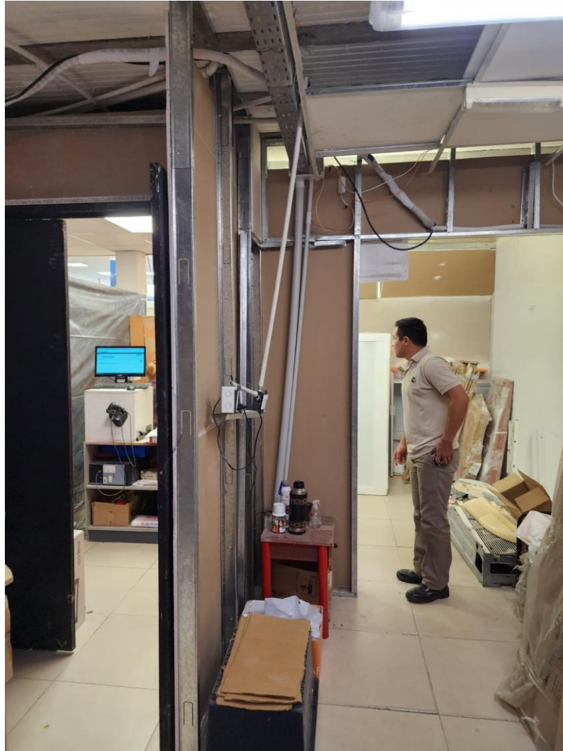
Fuente: Obra CETROGAR – Corrientes – Ing. Likoff
