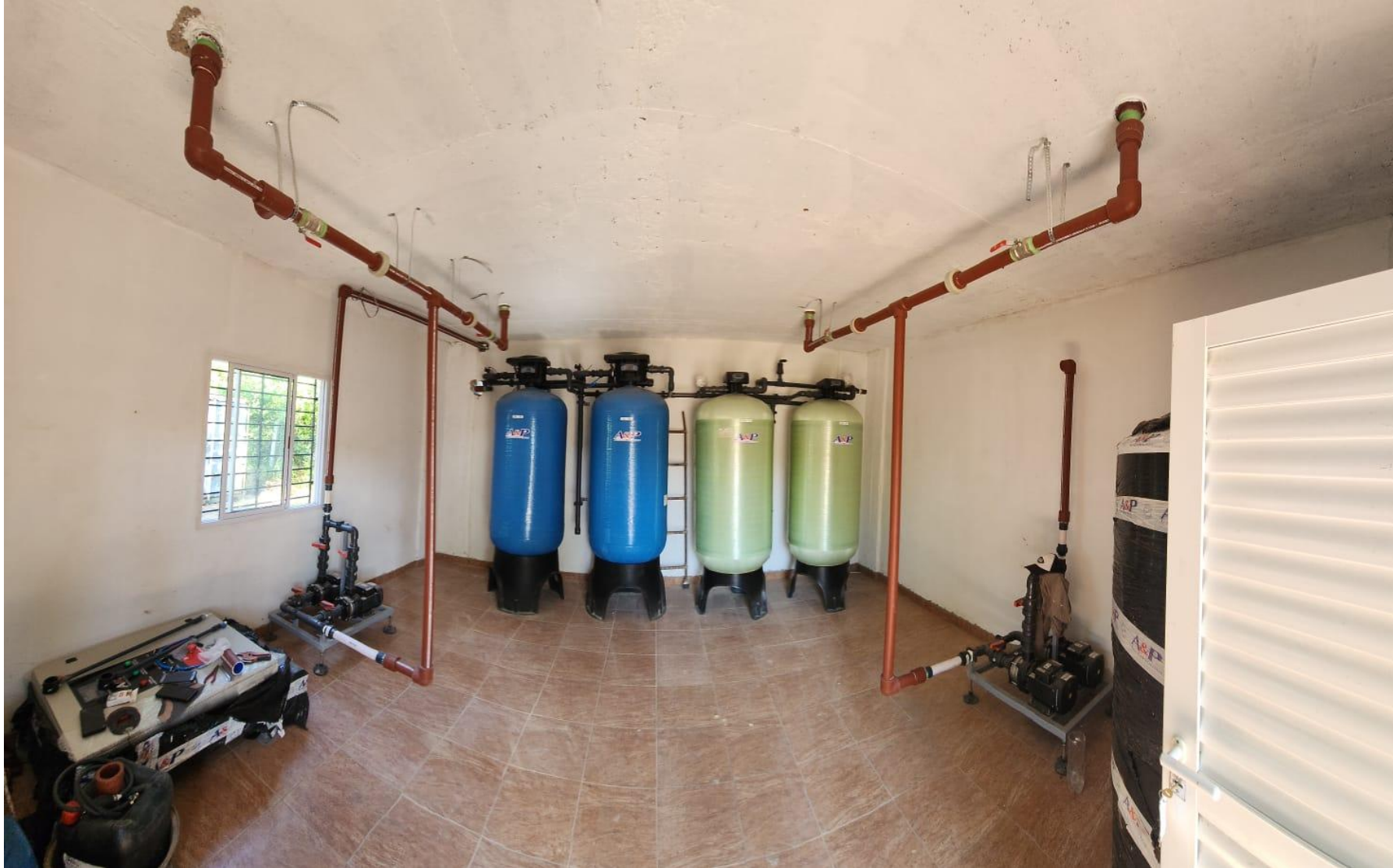
Fuente: Fotografía Obra Ing.Likoff – Planta potabilizadora de agua
