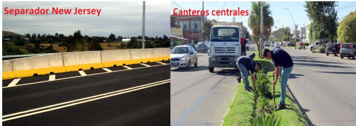
Figura IV.19. Separadores de hormigón. (Fuente: elaboración propia)
