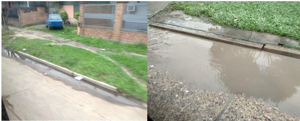
Figura VII.5. Acumulación de agua sobre la avenida. (Fuente: Elaboración propia)
