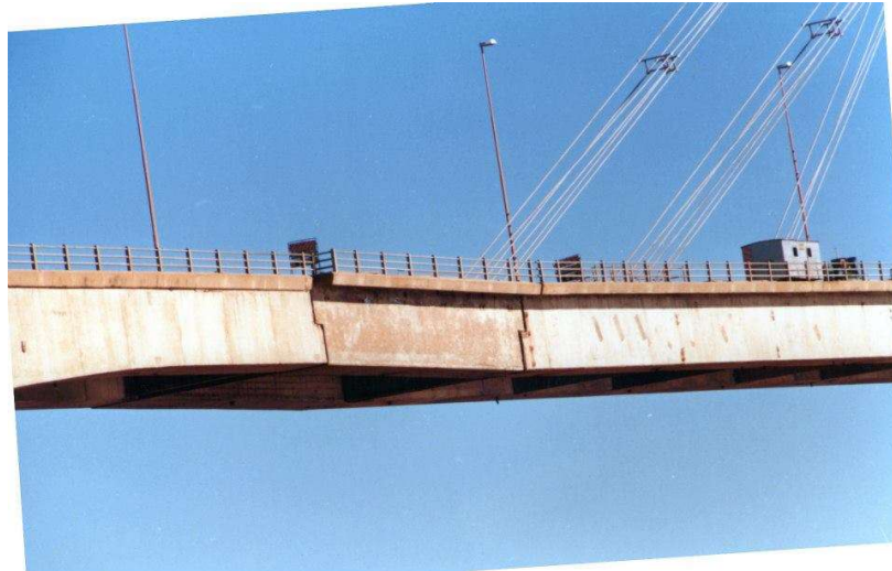
Fig. 7. Imagen del tablero del Puente. (Fuente: Vialidad Nacional )
