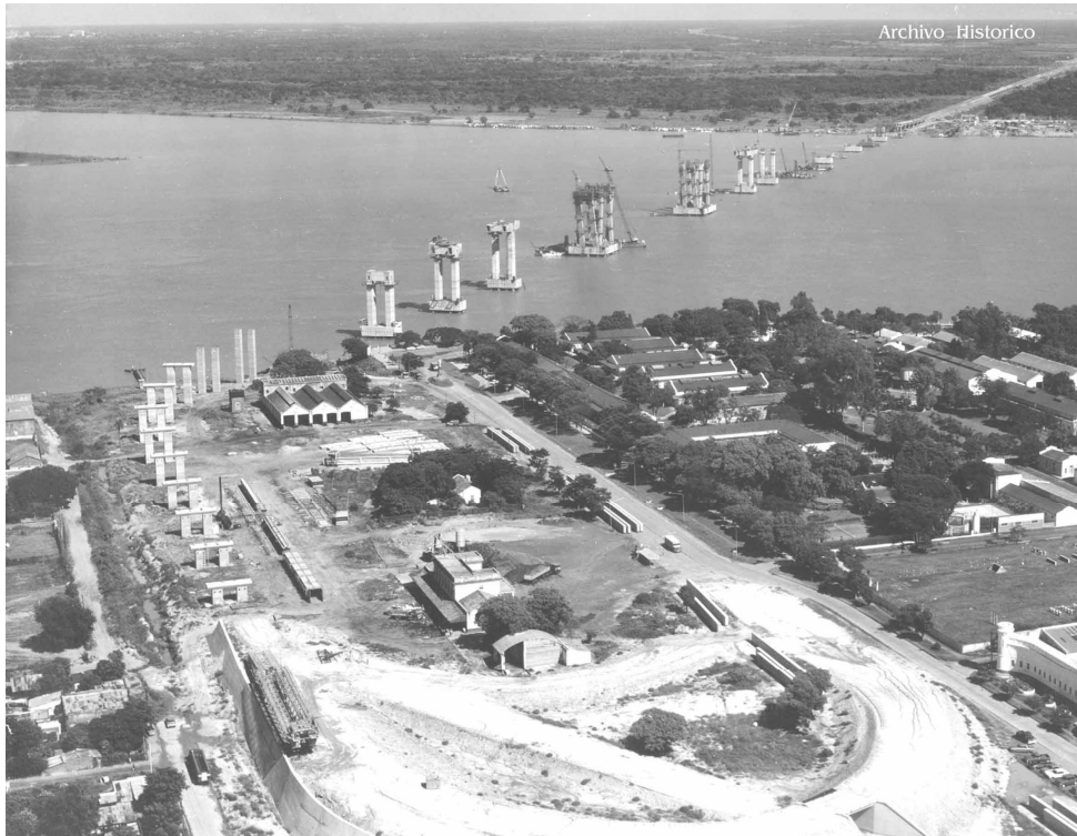
Fig. 2. Fotografía de los inicios de la construcción del Puente General Manuel Belgrano. (Fuente: Vialidad Nacional )
