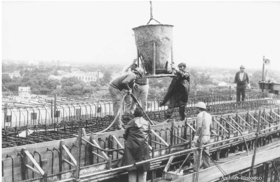
Fig. 3. Obreros trabajando en el hormigonado del Puente. (Fuente: Vialidad Nacional)
