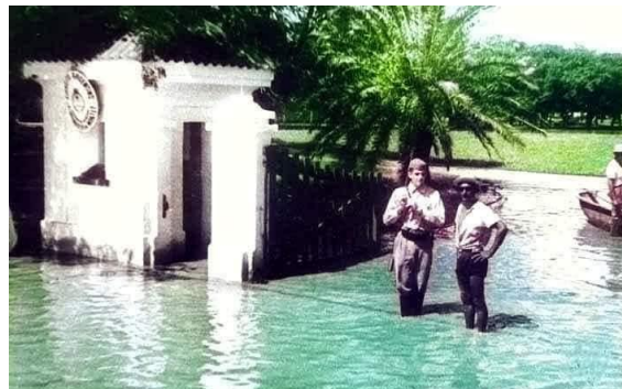
Figura 13. Inundación de 1966, Regimiento. (Fotos Antiguas de Resistencia, 2022)
