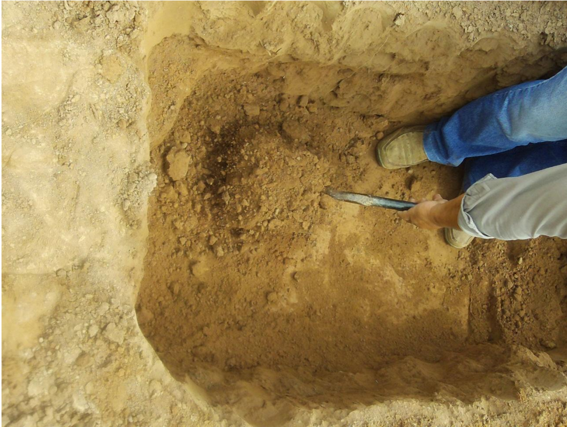
Imagen 3.5: calicata en la progresiva 18.700, labrada durante la campaña de estudio de suelo. - (Fuente: DVP- 2011).
