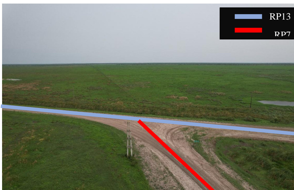
Imagen 7.4: intersección actual entre (RP7 - RP13). – (Fuente: Google Earth Pro).
