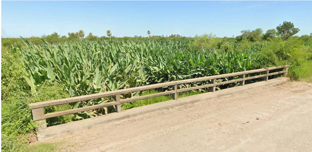
Imagen 4.12: alcantarilla 51. Sección rectangular y con barandas. Sobre el brazo norte del Río Tapenagá. - (Fuente: Google Earth Pro).
