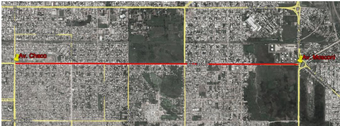
Figura 1.1. Tramo en estudio. Av. Castelli entre av. Chaco y Av. Mosconi. (Fuente: Google Earth, año 2.018)
