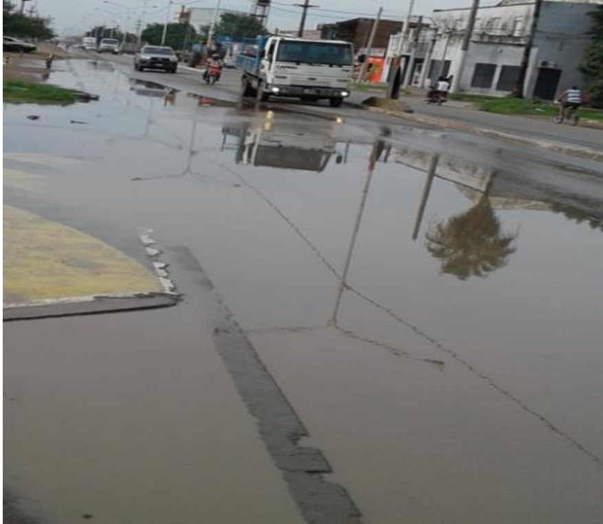
Figura A.1. Acumulación agua de lluvia en av. Castelli y calle Delfino. (Fuente: elaboración propia)
