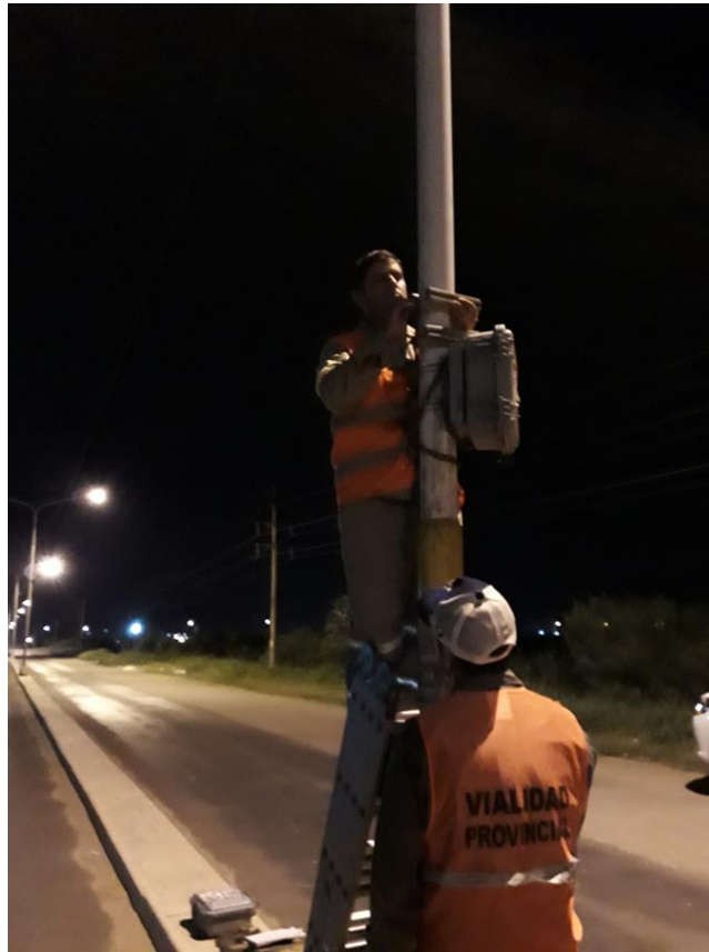
Figura A.11. Instalación del contador sobre av. Castelli en Barranqueras. (Fuente: DVP)
