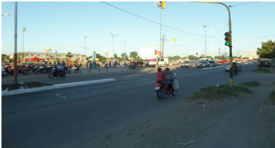
Figura 1.19. Falta de demarcación horizontal (línea de eje y senda peatonal). (Fuente: elaboración propia.)
