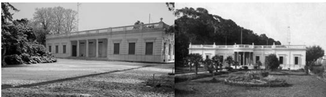
Figs. 8/9: Edificio ppal. (actual decanato y biblioteca): vistas norte (izq.) y sur (der.) Fuente: CEDIAP
