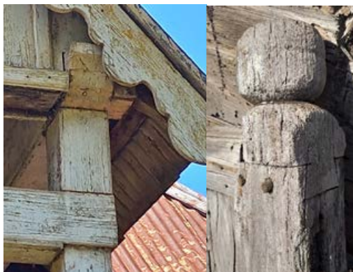
Figura 3. Encuentro en galería, ménsula con roleos. Fuente: elaboración propia.
