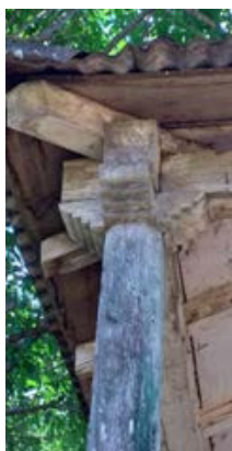
Figura 2. Detalle de encastres y despiece. Vivienda en Olegario Víctor Andrade, San Ignacio y Almafuerde, Misiones. Fuente: elaboración propia.
