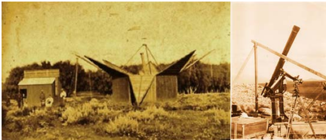
Figura 1. Casilla de Observación en Bragado (izq.) y pequeño ecuatorial Gautier (der.) Fuente: Archivo FCAG-UNLP
