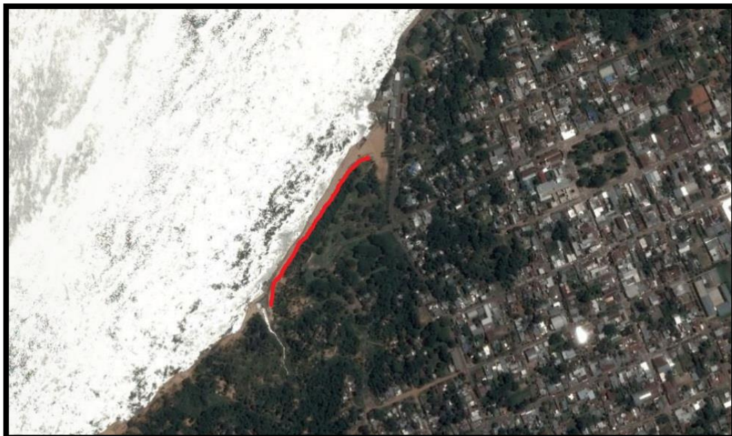
Figura 32: Traza adoptada para sistema de defensa de la ciudad de Bella Vista (fuente: elaboración propia con Google Earth. Año 2016).
