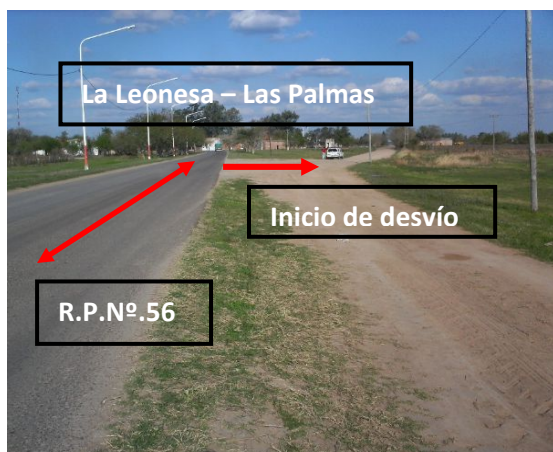
Foto N°1. Inicio de camino de acceso de tierra al puerto
