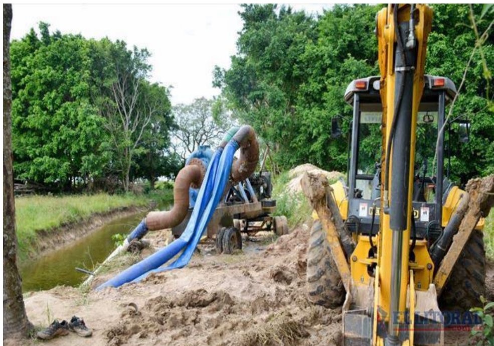
Figura 48. Apertura de canal en la laguna Soto
