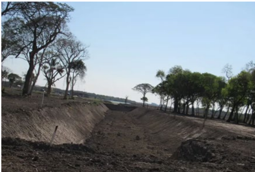
Figura 54. Construcción de canales en Santa Lucía
