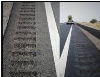
Imagen 50: Franjas fresadas
