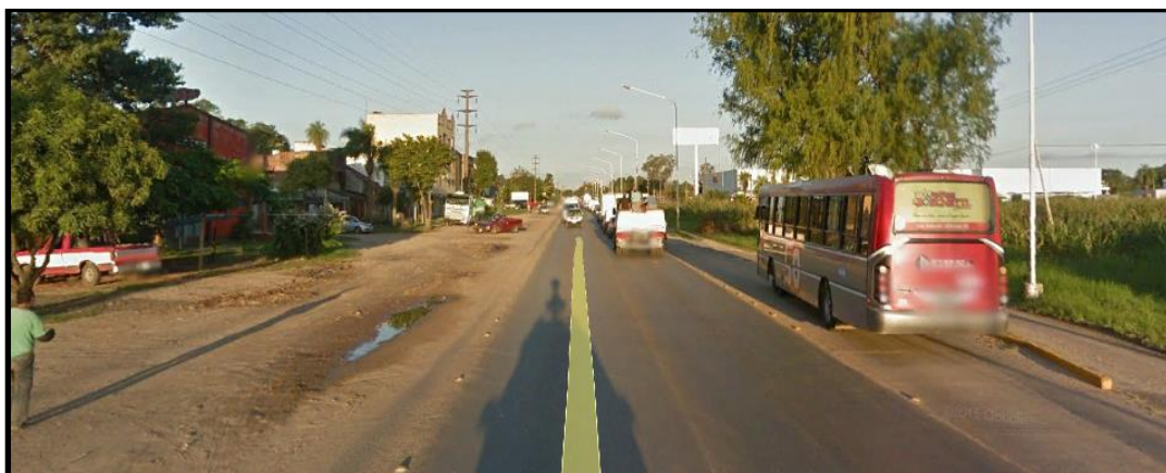
Imagen 7: Falta de pavimentación en Banquinas. Falta de señalización (Fuente: Google Maps)
