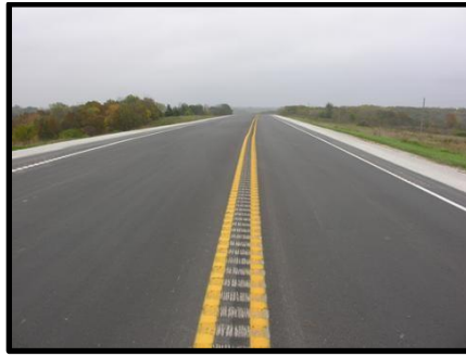
Imagen 48: Franja longitudinal en el borde de la calzada
