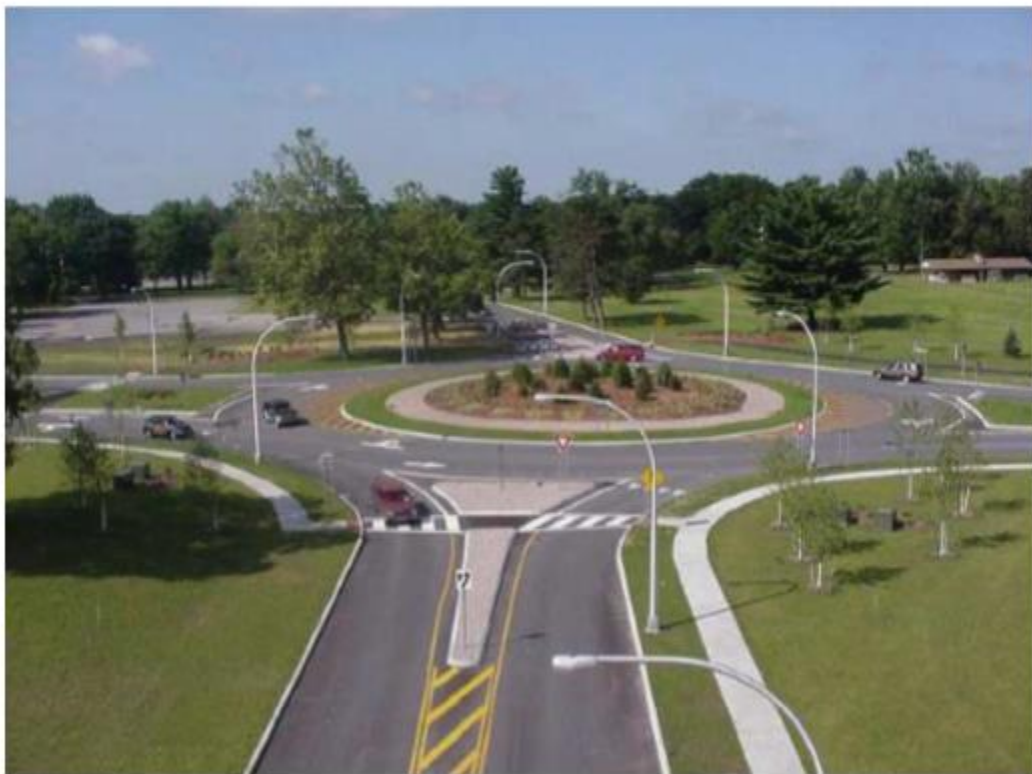
Figura 5.7: Señalización vertical y horizontal en una RM.
