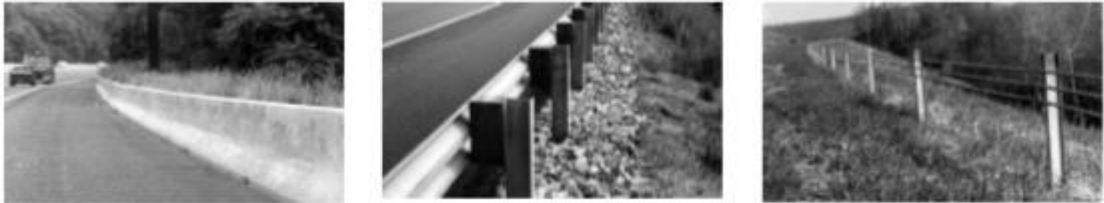
Figura 5.12: Tipologías de barreras longitudinales.
