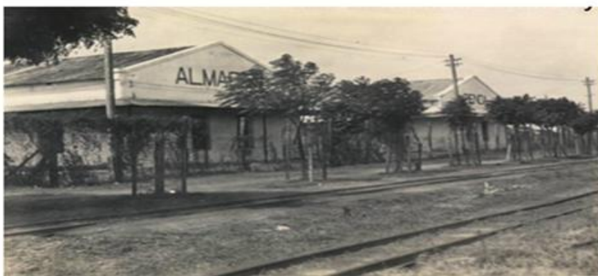
Foto N° 1.1. Almacenes de la Fábrica azucarera Las Palmas S.A.
