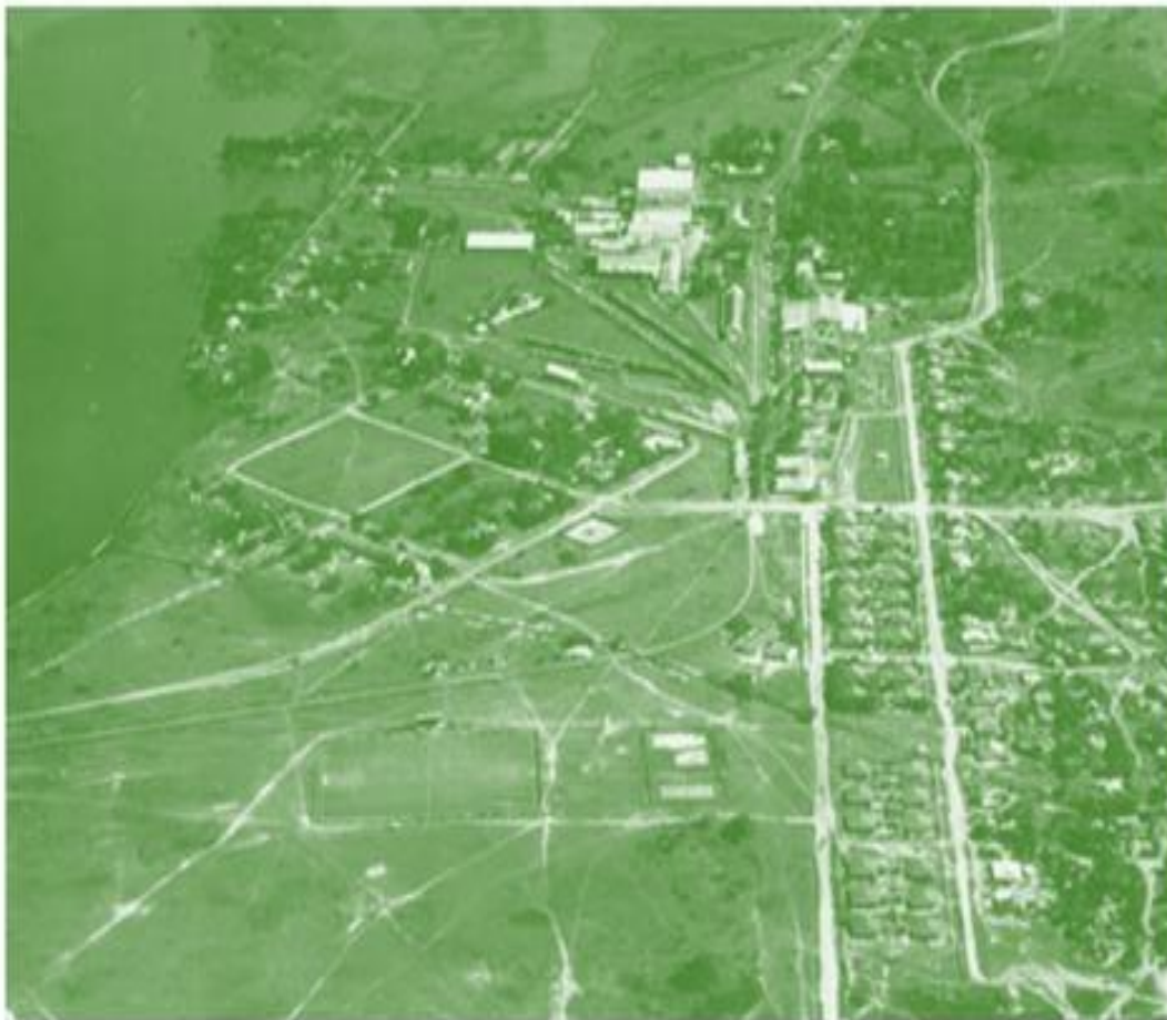
FOTO N° 2 Imagen aérea de la localidad de Las Palmas. Ex ingenio Las Palmas. Año 1971
