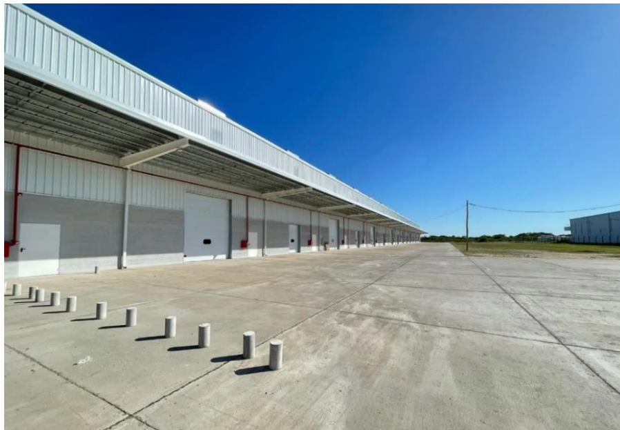
Imagen 11: Fotografía por fuera del galpón (conjunto de módulos de galpones). Fuente: www.buscainmueble.com .
