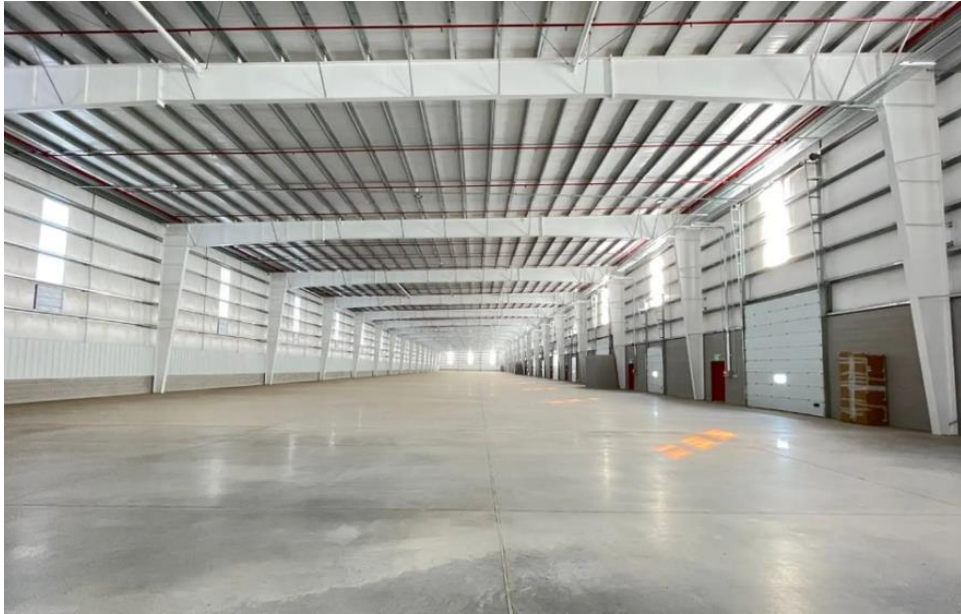
Imagen 12: Fotografía del interior del galpón. Fuente: www.buscainmueble.com .
