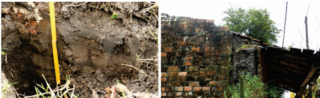
Figura 8. Izq. Detalle de cimentación con adobe. Der. Detalle de recubrimiento de paredes con ladrillos de pandereta. Fuente: Salas (2018).
