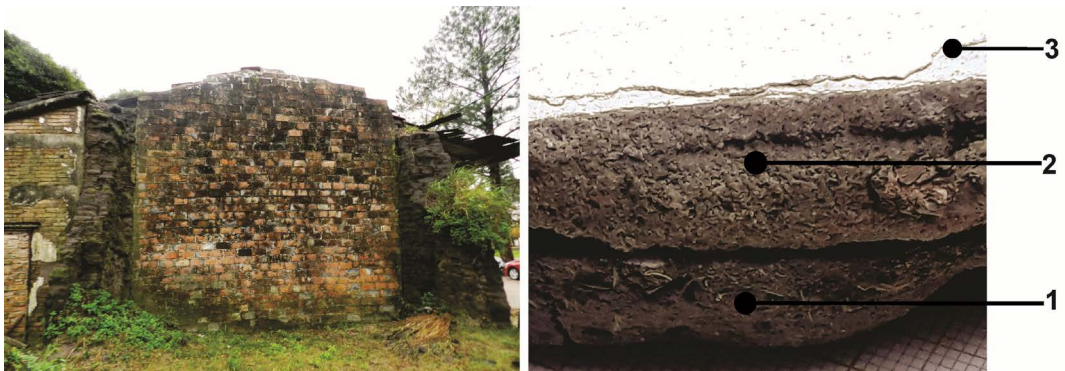
Figura 5. Izq. Restos de muros de antiguas habitaciones hacia la esquina. Der. Detalle de capas de revoque, terminación final de la pared de adobe: 1) Primera capa de tierra de 1 cm de espesor; 2) Segunda capa de tierra de 8 mm de espesor; 3) Capas de pintura de cal superpuestas. Fuente: Piñeiro (2024).
