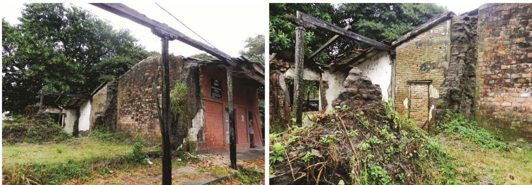
Figura 3. Izq. Vista lateral de la casa y el sitio. Se observan vigas y columnas de galerías de locales desaparecidos y restos de muro de adobe en estado de ruina. Fuente: Salas (2018).
