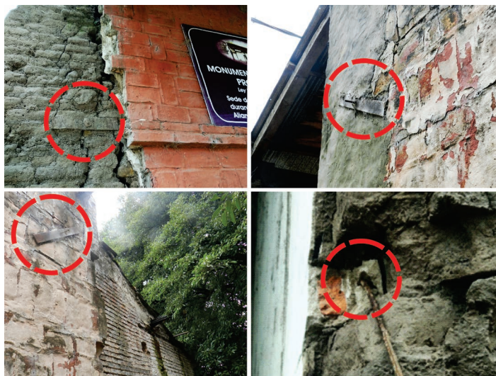
Figura 9. Detalle de tensores metálicos en muros, arriba, izq., pared del frente. Der. Muro hacia el lote, frente. Abajo, izq., pared hacia el lote y patio. Der. Detalle de hierro y cemento. Fuente: Salas (2018).
