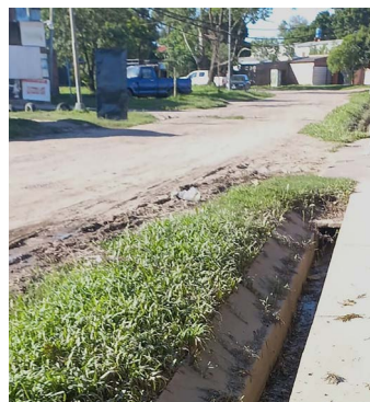
Figura 14. Zanjas laterales a las aceras. Fuente: Archivo fotográfico propio (diciembre de 2023).
