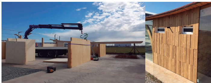
Figura 1. Izq; Proceso de montaje de los paneles y Der; Imagen de las oficinas SITSA finalizadas. Fuente: Maderamen (2020).
