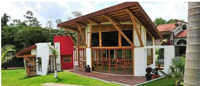
Figura 4. Fotografías ilustrativas de resultados de conjunción de guadua para columnas, vigas, paramentos y entramado estructural de techo. Fuente: fotografías obtenidas mediante la propia autora de la obra, Arq. Carolina Zuluaga Zulueta, Colombia.
