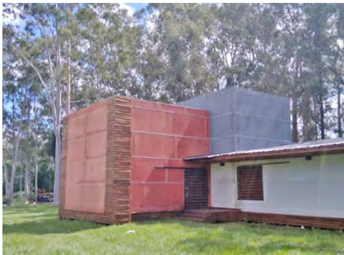
Figura 1. Vivienda de madera con recubrimiento de placas cementicias y construcción en seco en Santa Ana, Corrientes. Fuente: fotografía propia
