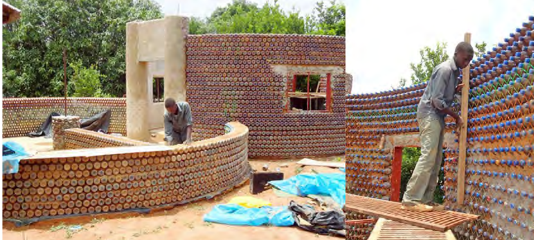
Figura 4. Casa de botellas de plástico en Nigeria. Fuente: Reyes Palapa (2013)
