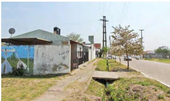
Figura 6. Canal de desagüe pluvial a cielo abierto con talud cubierto de césped que contribuye a frenar la erosión. Foto: V. Valenzuela, 2021
