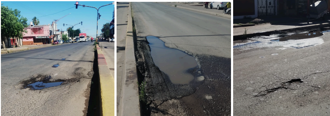
Figura 1.11: Calzada central (Imagen 1 y 2) y calzada lateral (Imagen 3) con presencia de baches profundos (Fuente: Elaboración propia).
