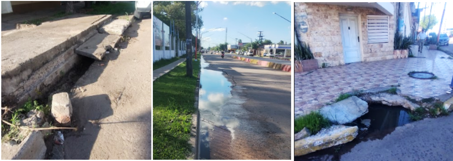
Figura 1.14: Falta de mantenimiento de desagües pluviales y cloacales (Fuente: Elaboración propia)
