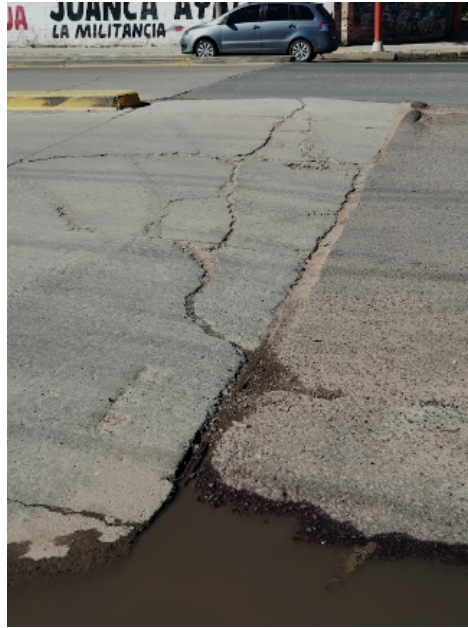
Figura 1.10: Calzada en colectora lateral con cambio de composición en el paquete. Presencia de grietas transversales con desprendimiento de material. (Fuente: Elaboración propia).
