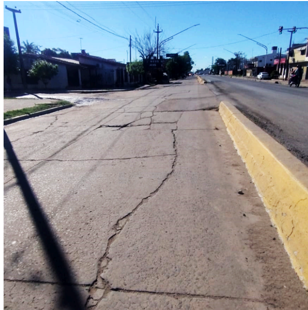
Figura 1.12: Calzada lateral con presencia de grietas longitudinales y laterales, junto a desprendimiento de material y bacheos. (Fuente: Elaboración propia)
