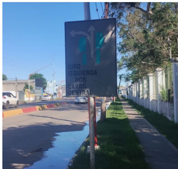
Figura 1.9: Deterioro de la señalización (Fuente: Elaboración propia).
