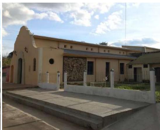
Figura 17: Vista de la Capilla/Museu en San Miguel. Fuente: Luciana Sudar.
