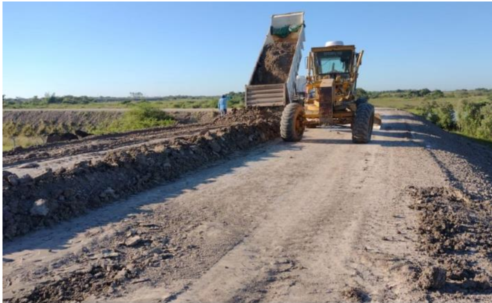
Fotografías 6.3. Terraplén del anillo de defensa y la estación de bombeo
