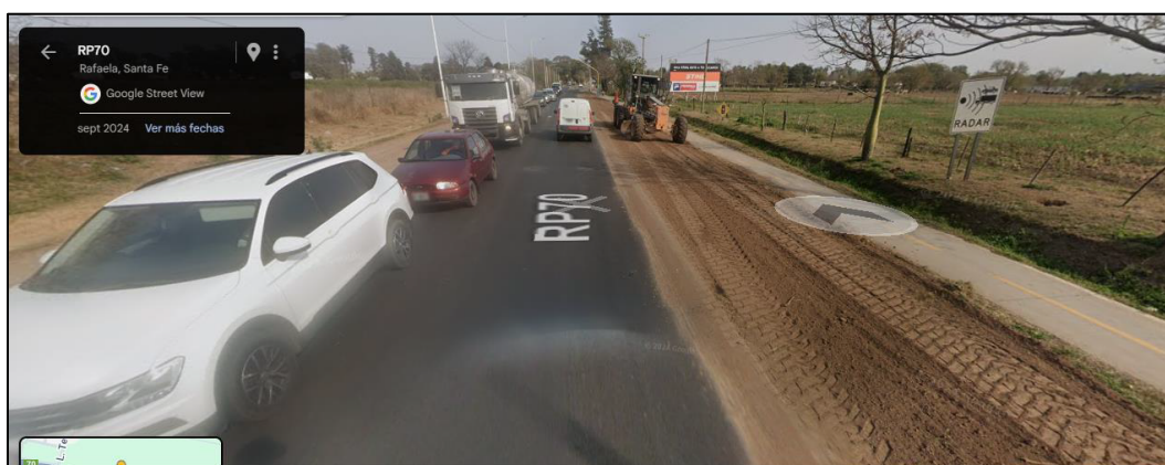
Figura 1.5. Obras en banquetas, Ruta Provincial N°70 localidad de Rafaela. Fuente: Adaptado del sitio web de Google Maps, 2025.
