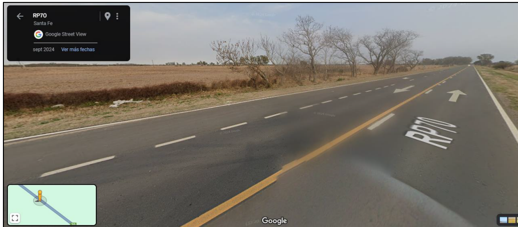
Figura 1.6. Carril adicional de sobrepaso, Ruta Provincial N°70. Fuente: Adaptado del sitio web de Google Maps, 2025.
