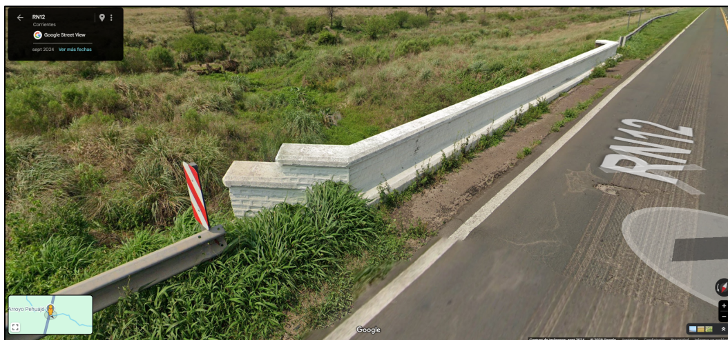
Figura 8.26. Barrera de puente de mampostería. Fuente: Adaptado del sitio web de Google Maps, 2025.
