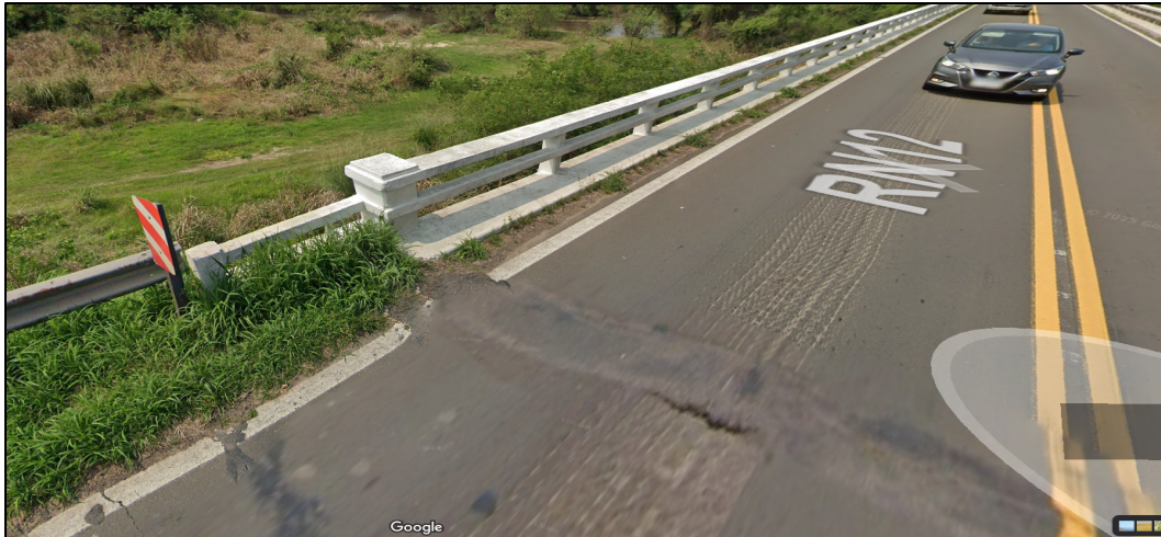
Figura 8.27. Barrera de puente de hormigón. Fuente: Adaptado del sitio web de Google Maps, 2025.
