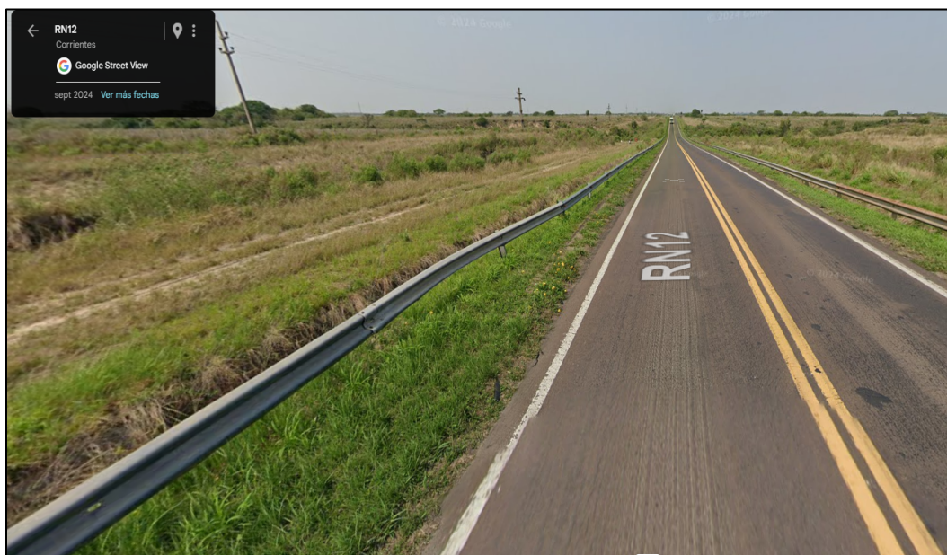
Figura 8.20. Barreras metálicas semirrígidas tipo W-beam en arroyo González. Fuente: Adaptado del sitio web de Google Maps, 2025.
