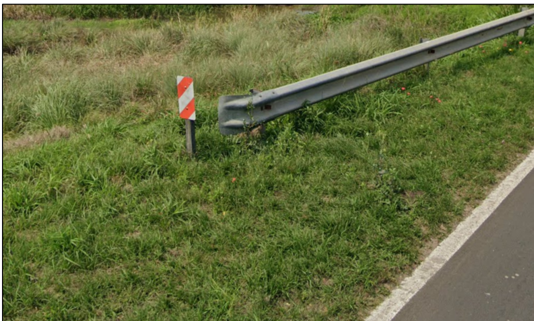
Figura 8.24. Extremos inseguros de barreras metálicas. Fuente: Adaptado del sitio web de Google Maps, 2025.
