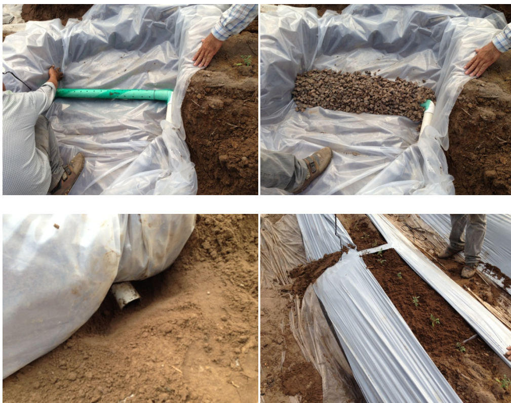
Figura 16 - Etapas de la fabricación e instalación de un lisímetro de drenaje.
