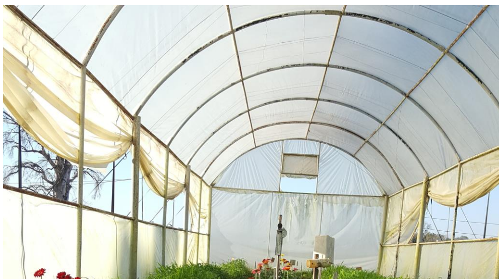
Imagen 28: Vista de los laterales del invernadero levantados (Fuente: García, F.)
