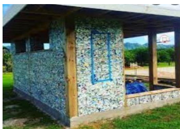
Figura 14: Foto ejemplo de paredes con byfusion
