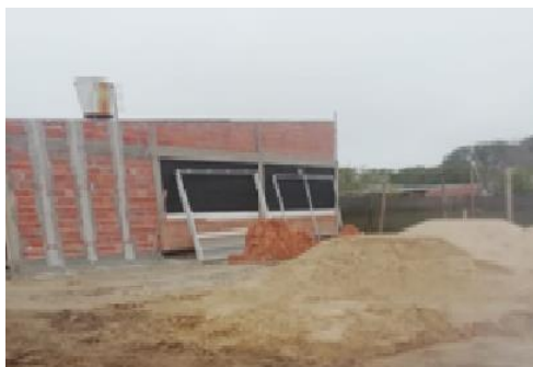
Figura 12: Fajas de Revoques. JIN N°17 en Escuela N°605. Cañada Quiroz
