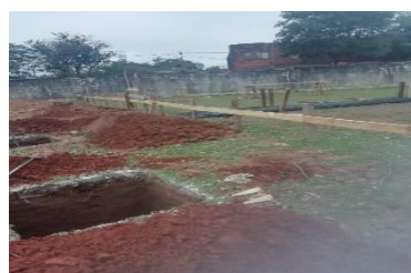
Figura 31: Replanteo de obra Jardín N°46
