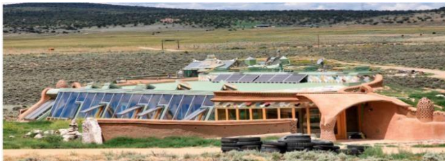
Figura 36: Tipología de construcción “Eathship” con los correspondientes paneles solares colocados
