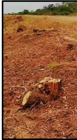
Figura 5.14 Raíces de vegetación, por mantenimiento defectuoso, en terraplén de defensa del AMGR (Fuente: Elaboración propia).
