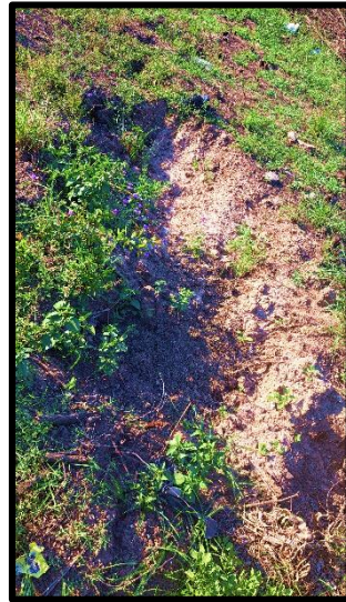
Figura 5.12 Cárcavas en terraplén de defensa del AMGR (Fuente: elaboración propia).
