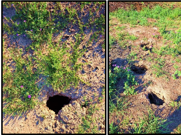
Figura 5.11 Tubificaciones en terraplén de defensa del AMGR (Fuente: elaboración propia).
