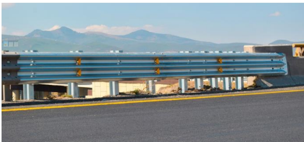
Fotografía 3.1. Empalme de barrera rígida con barrera semirígida. (Fuente: ManufacturasCarmen)
