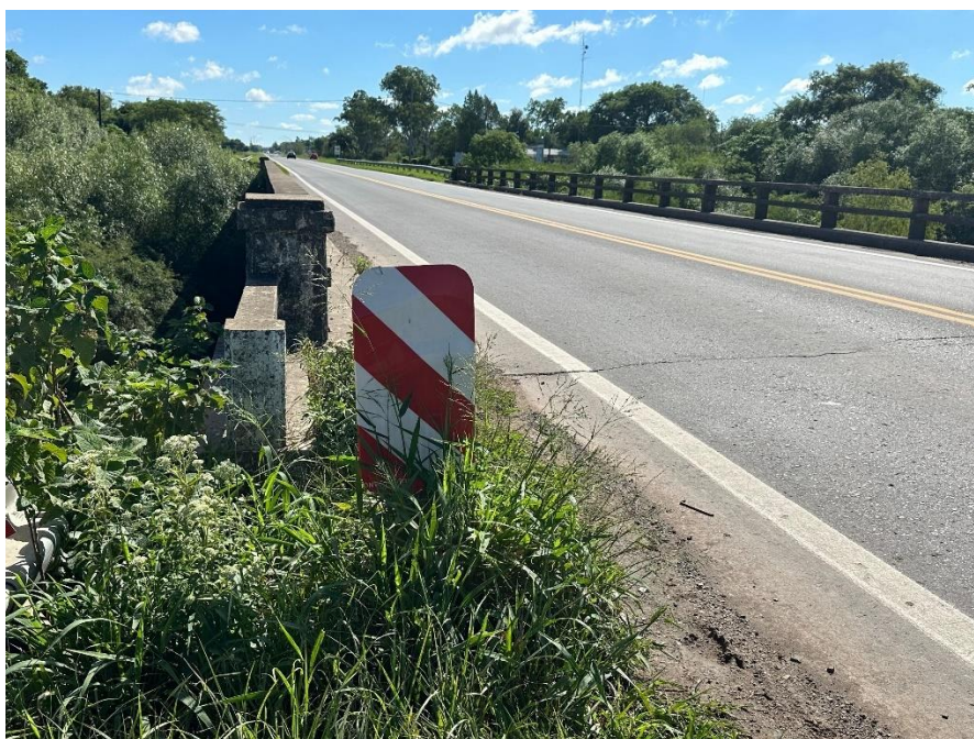
Fotografía 2.51. Falta de continuidad entre defensas. (Fuente: Elaboración propia).
