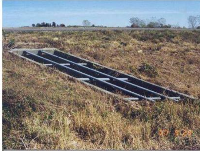
Fotografía 3.5. Ejemplo de solución de rejas en alcantarillas. (Fuente: C7, Norma DNV).
