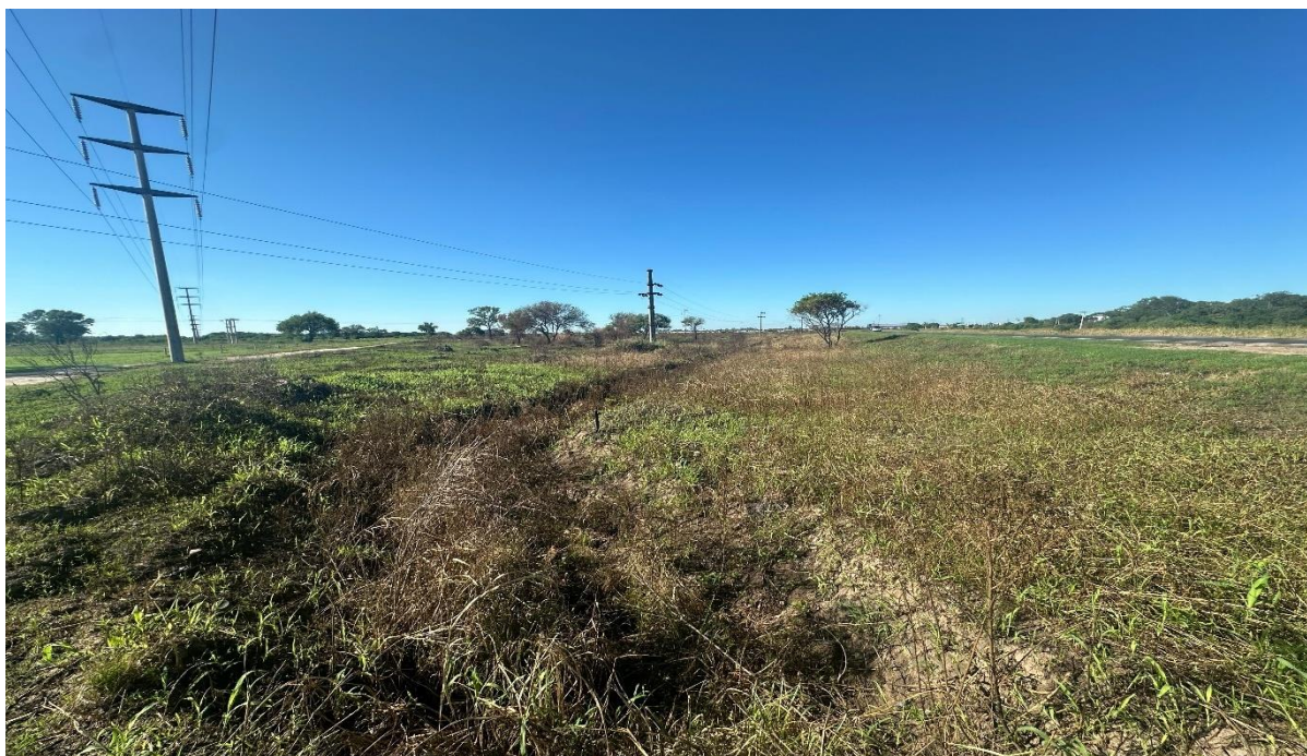
Fotografía 2.19. Cunetas no transitables. (Fuente: Elaboración Propia).
