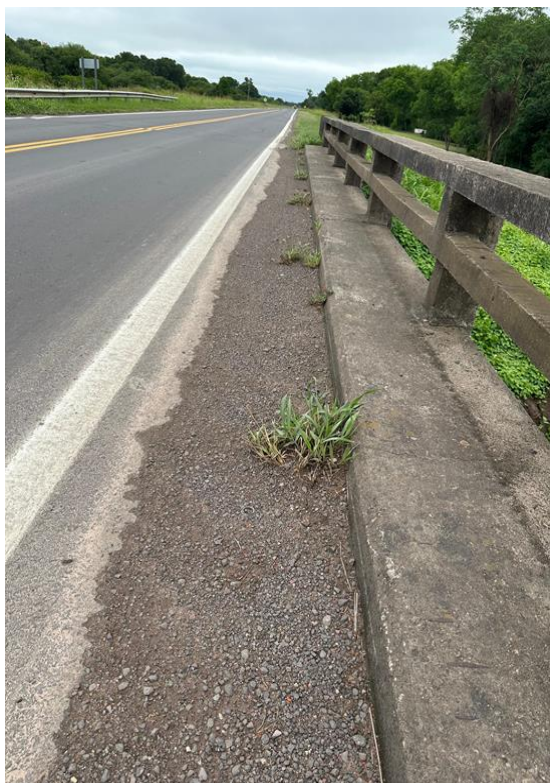
Fotografía 2.50. Falta de mantenimiento en sistemas de drenaje. (Fuente: Elaboración propia).
