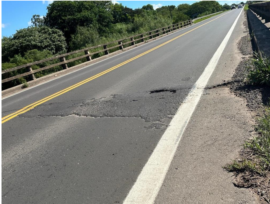
Fotografía 2.54. Inexistencia de junta de dilatación y losa de aproximación. (Fuente: Elaboración propia).
