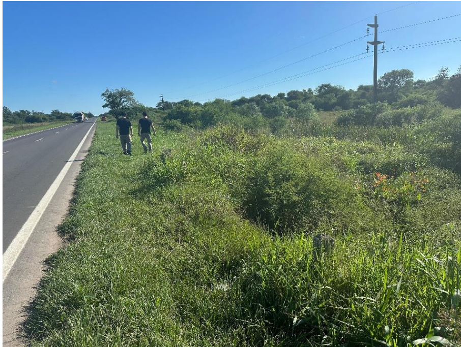
Fotografía 2.56. Alcantarilla sin defensa y poco visible. (Fuente: Elaboración propia).
