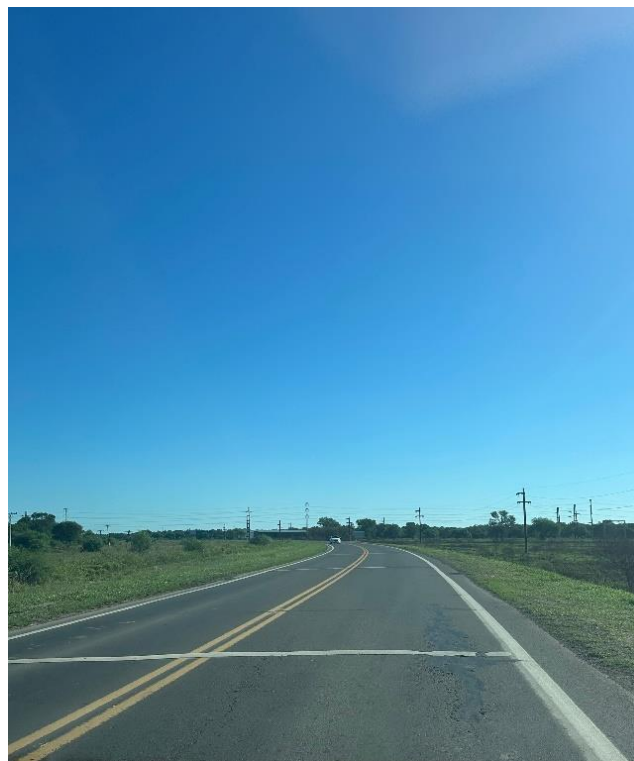
Fotografía 2.79. Correcta señalización horizontal de curva: Línea blanca transversal de disminución de velocidad. (Fuente: Elaboración propia).
