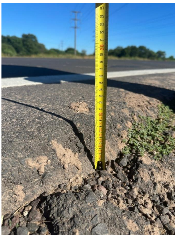
Fotografía 2.9. Caída del borde de pavimento de 10 cm. (Fuente: Elaboración propia).
