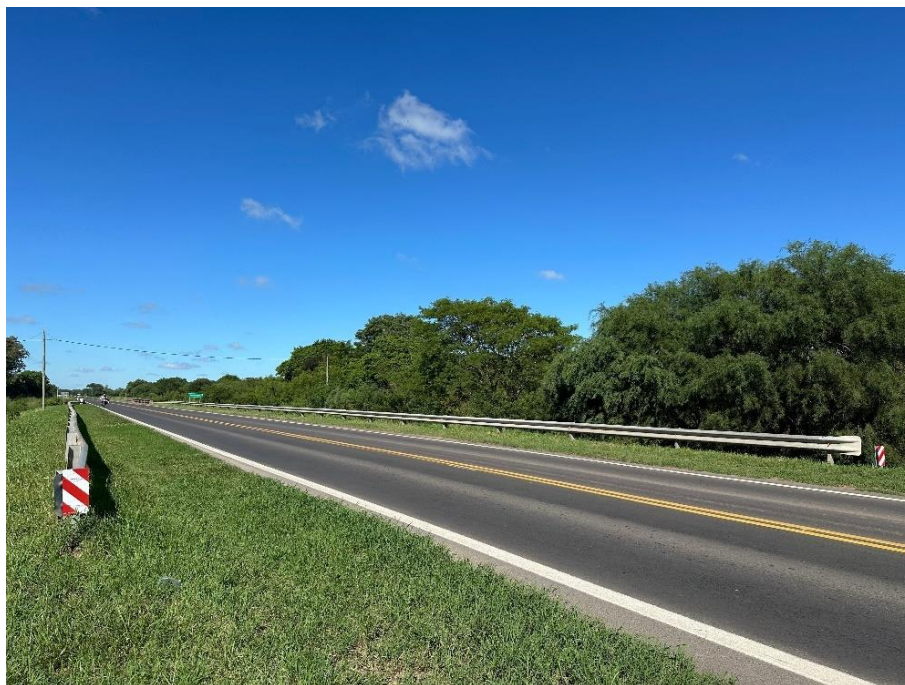
Fotografía 2.37. Defensa semirrígida antes del Puente sobre el Río Tragadero. (Fuente: Elaboración propia).
