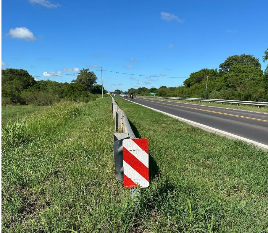
Fotografía 2.38. Defensa semirrígida antes del Puente sobre el Río Tragadero. (Fuente: Elaboración propia).
