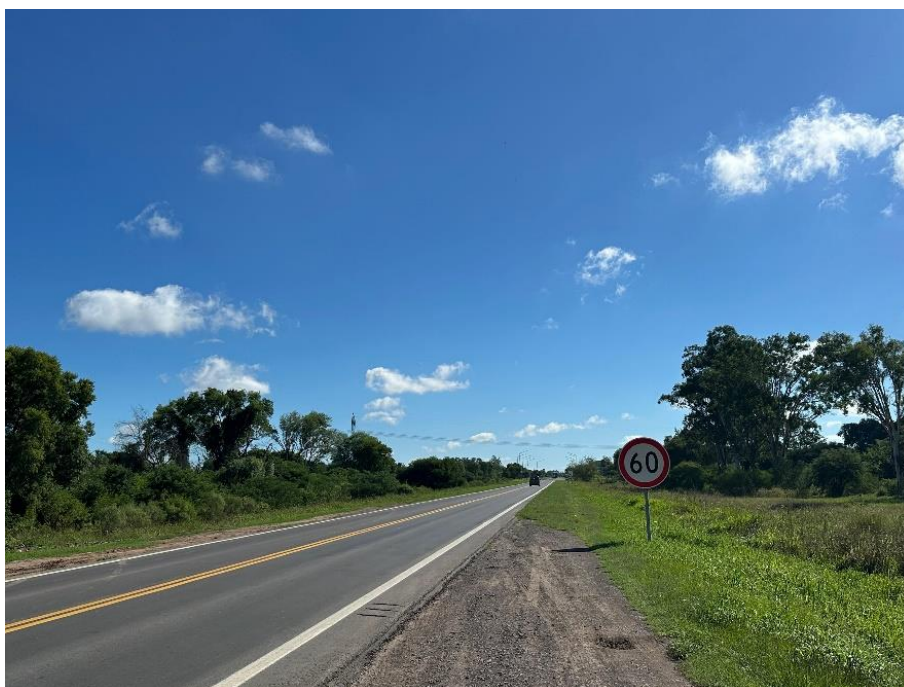
Fotografía 2.95. Señales verticales de escalonamiento de velocidades incorrectas. (Fuente: Elaboración propia).
