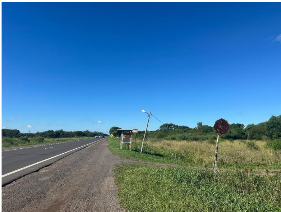
Fotografía 2.105. Ausencia de dársenas y postes de luz caídos. (Fuente: Elaboración propia).
