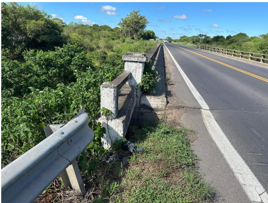
Fotografía 2.40. Transición entre defensas inadecuada. (Fuente: Elaboración propia).
