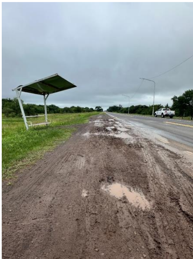
Fotografía 2.6. Estado de las banquinas (Fuente: Elaboración propia)
