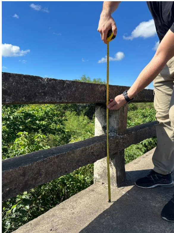
Fotografía 2.43. Altura de defensa rígida insuficiente. (Fuente: Elaboración propia).
