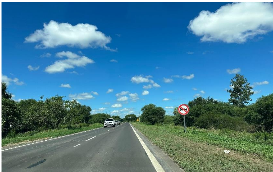
Fotografía 2.81. Correcta señalización vertical en curvas: Cartel de prohibición de sobrepaso. (Fuente: Elaboración propia).
