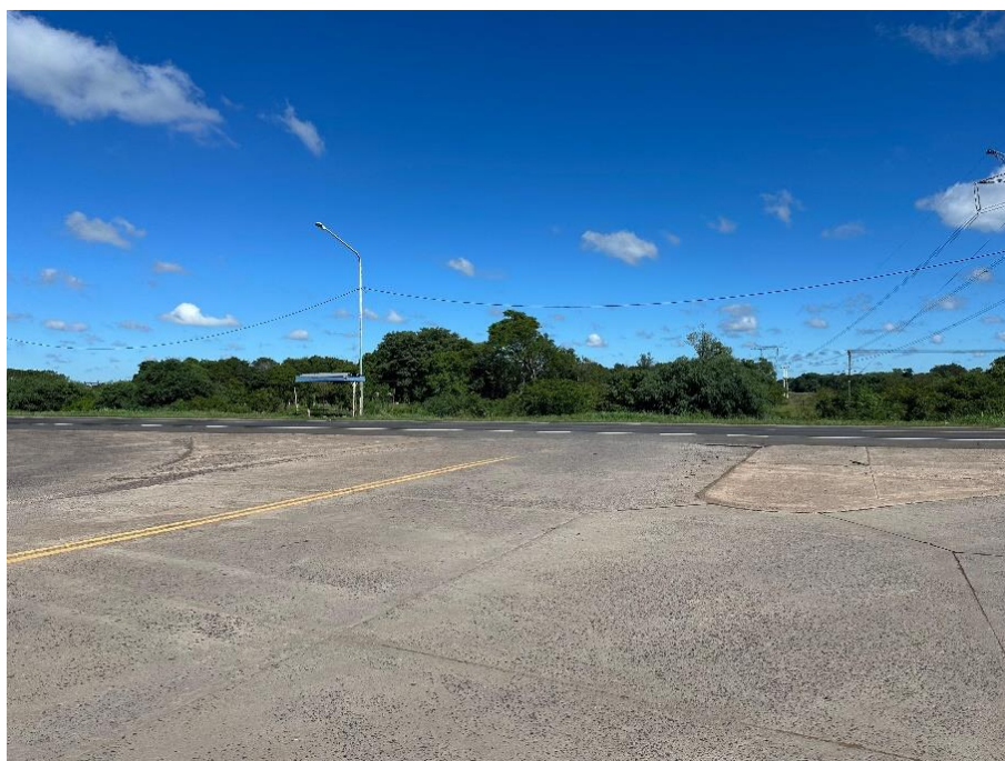
Fotografía 2.91. Isletas presentes en intersección sin señalamiento horizontal. (Fuente: Elaboración propia).
