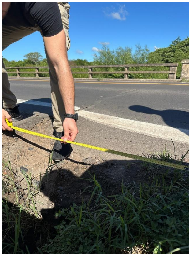
Fotografía 2.47. Hundimiento del pavimento en ingreso al puente. (Fuente: Elaboración propia).
