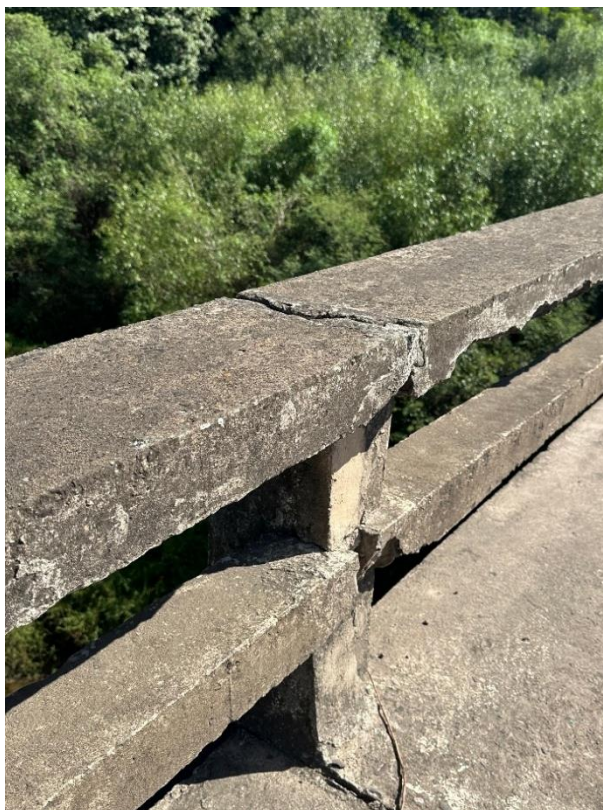
Fotografía 2.44. Presencia de fisuras en defensa rígida. (Fuente: Elaboración propia).
