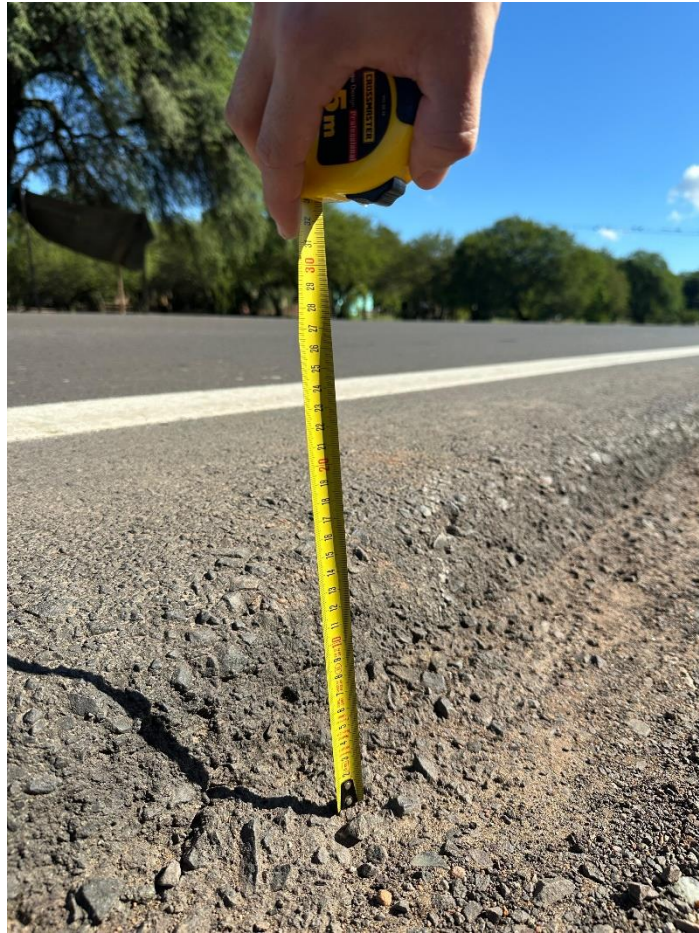
Fotografía 2.10. Caída del borde de pavimento de 15 cm. (Fuente: Elaboración propia).
