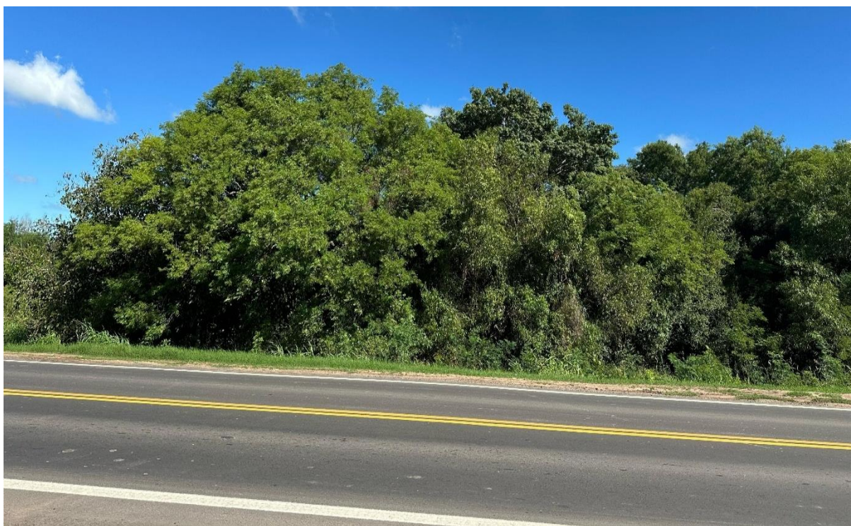
Fotografía 2.13. Falta de mantenimiento en Zona Despejada. (Fuente: Elaboración propia).
