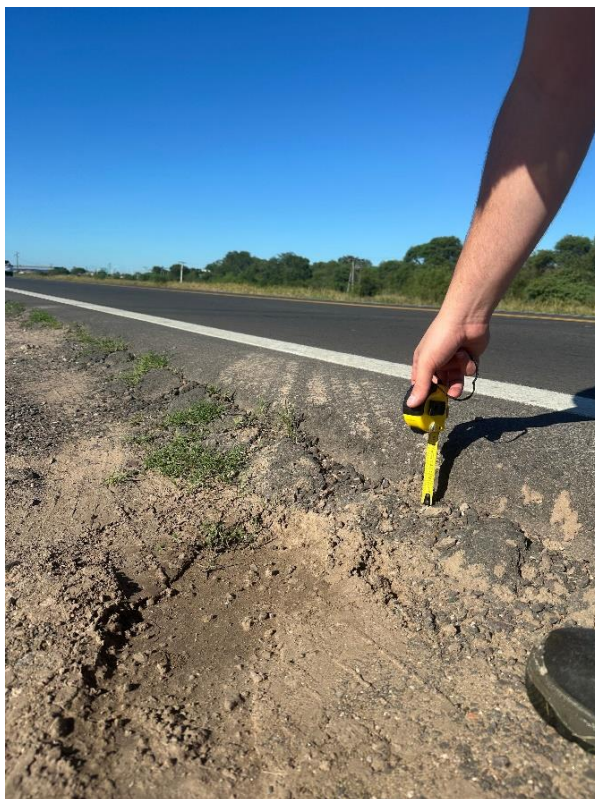
Fotografía 2.8. Caída del borde de pavimento (Fuente: Elaboración propia).
