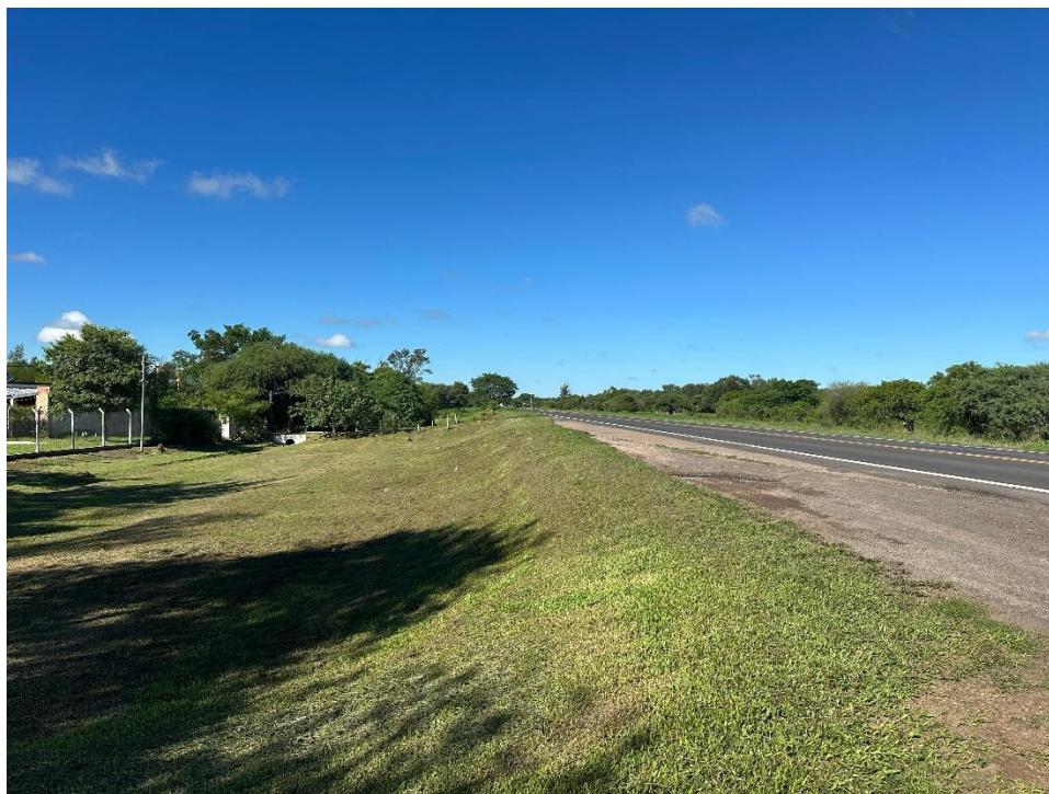
Fotografía 2.16. Inclínación excesiva de Taludes. (Fuente: Elaboración propia).
