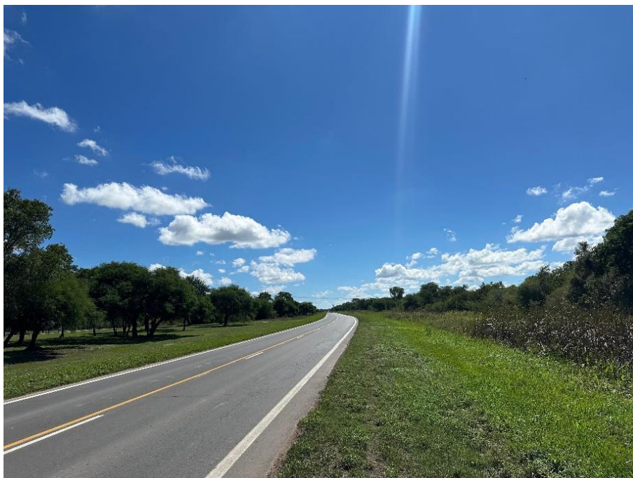
Fotografía 2.80. Curva amplia con buena visibilidad y señalamiento horizontal de permiso de sobrepaso. (Fuente: Elaboración propia).
