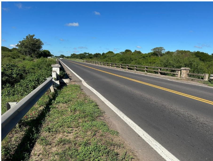
Fotografía 2.39. Ausencia de banquetas en Puente. (Fuente: Elaboración propia).
