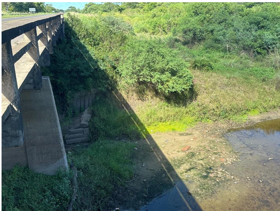
Fotografía 2.53. Taludes desprendidos. (Fuente: Elaboración propia).
