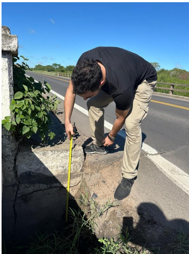
Fotografía 2.46. Hundimiento del terraplén en ingreso al puente. (Fuente: Elaboración propia).
