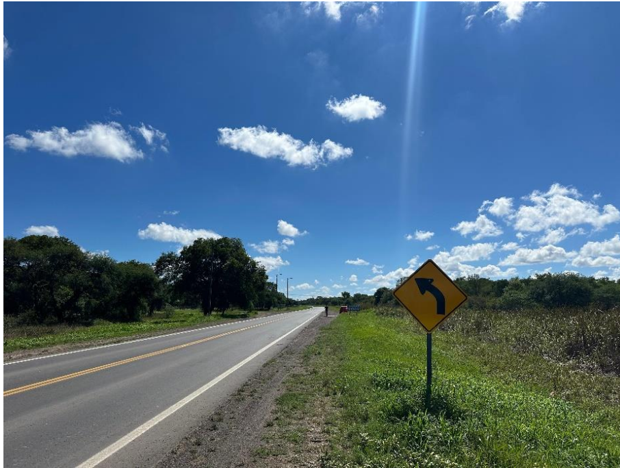
Fotografía 2.78. Correcta señalización de curvas. (Fuente: Elaboración propia).
