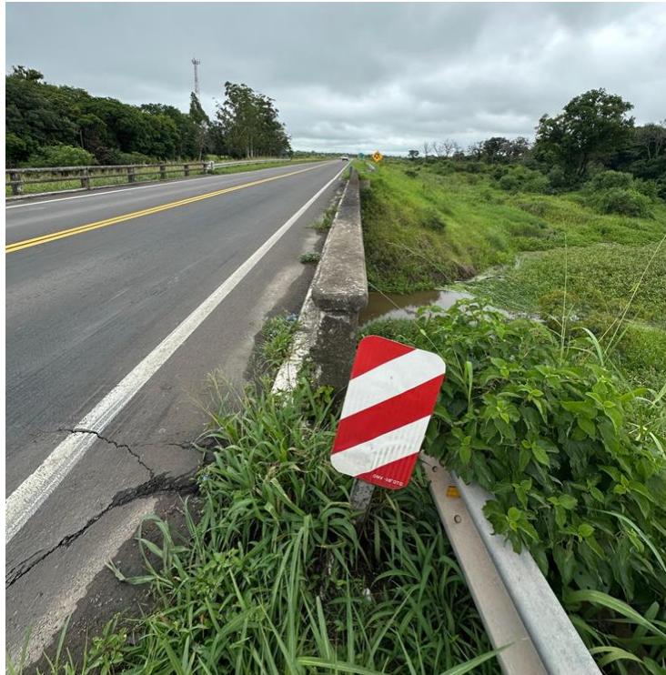
Fotografía 2.52. Severa falta de mantenimiento, defensas caídas. (Fuente: Elaboración propia).
