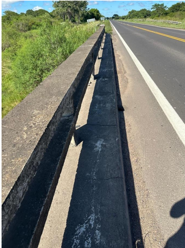
Fotografía 2.42. Baranda rígida sin mantenimiento. (Fuente: Elaboración propia).
