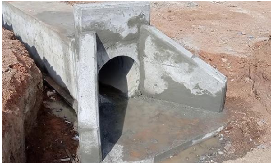
Fotografía 3.2. Alcantarilla tipo box de hormigón. (Fuente: BIM CIVIL).
