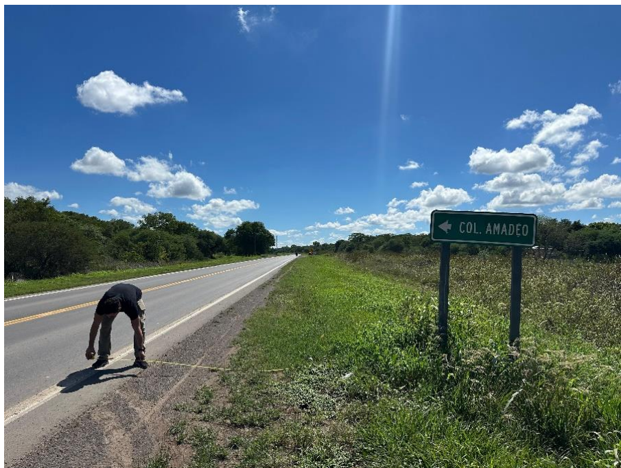
Fotografía 2.87. Distancia adecuada de señales verticales desde la calzada (4,2 metros). (Fuente: Elaboración propia).
