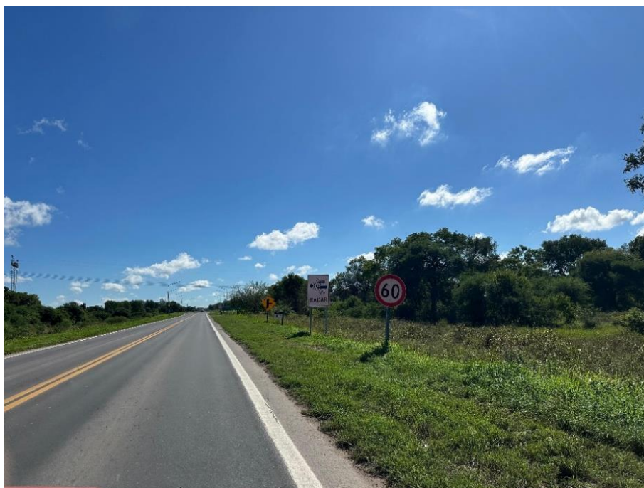
Fotografía 2.93. Adecuada distancia entre señales verticales. (Fuente: Elaboración propia).
