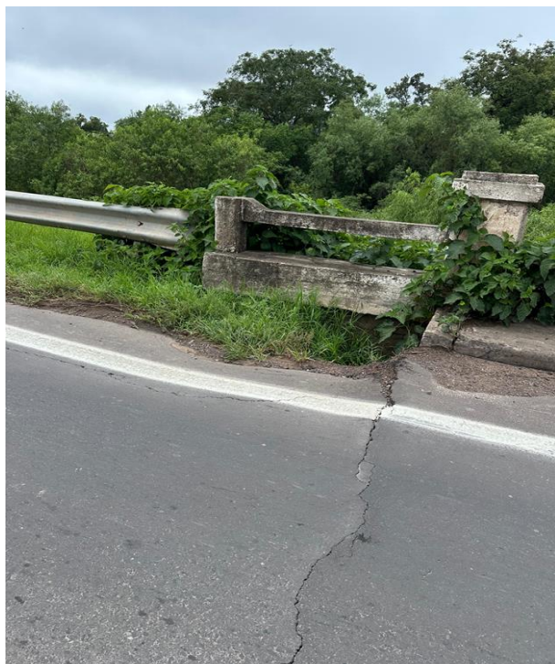
Fotografía 2.49. Hundimiento y fisuras en pavimento por falla del terraplén. (Fuente: Elaboración propia).
