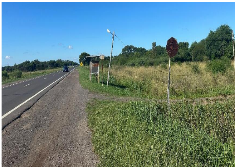
Fotografía 2.98. Señal vertical de presencia de parada de ómnibus en mal estado. (Fuente: Elaboración propia).
