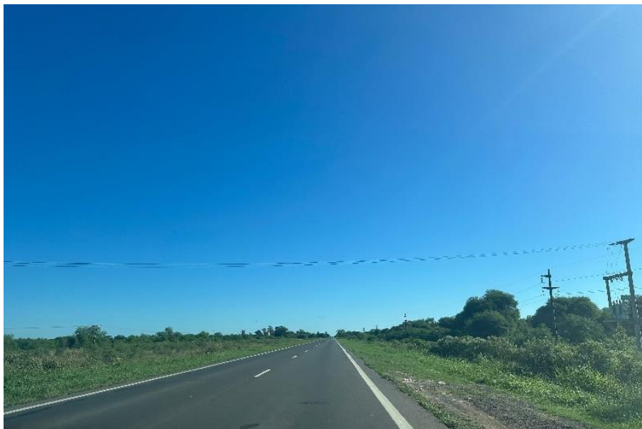
Fotografía 2.76. Correcto señalamiento horizontal en tramo recto: Línea discontinua. (Fuente: Elaboración propia).
