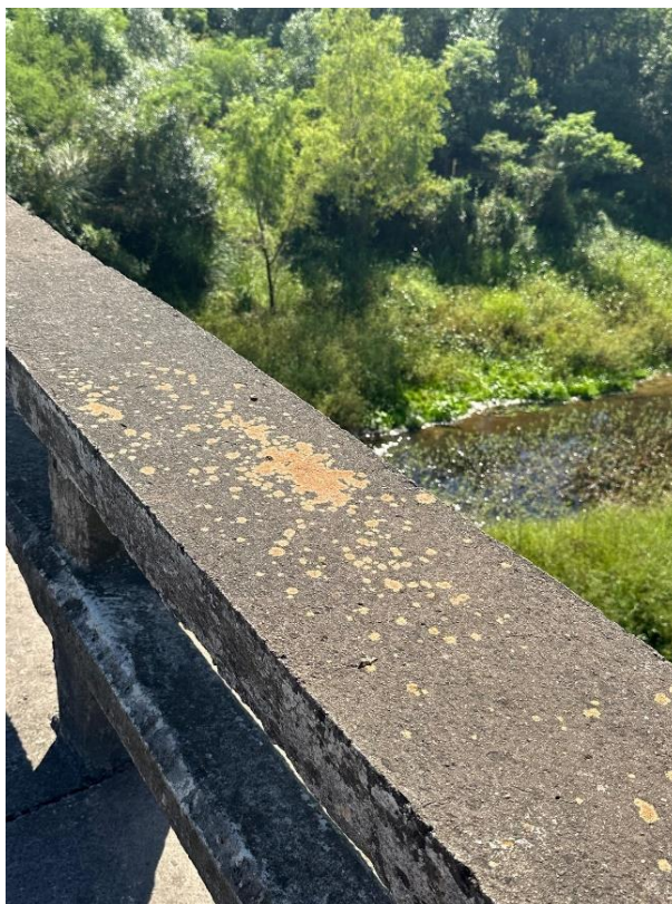
Fotografía 2.45. Falta de mantenimiento en defensa. (Fuente: Elaboración propia).
