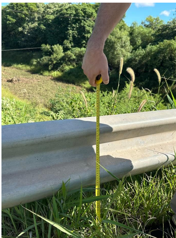
Fotografía 2.41. Altura de defensa semirigida insuficiente. (Fuente: Elaboración propia).
