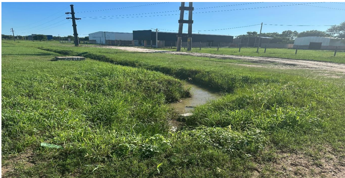
Fotografía 2.20. Cunetas no transitables. (Fuente: Elaboración Propia).
