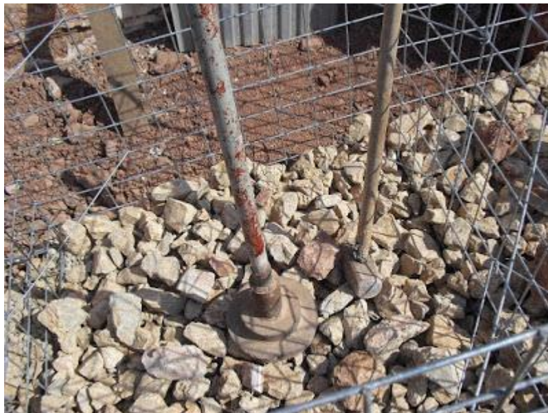
Figura 6.14: Imagen ilustrativa de llenado de gavión y colocación de tensores ( http://nuestracasacontenedor.blogspot.com/2016/04/muro-grande-de-gaviones.html ).
