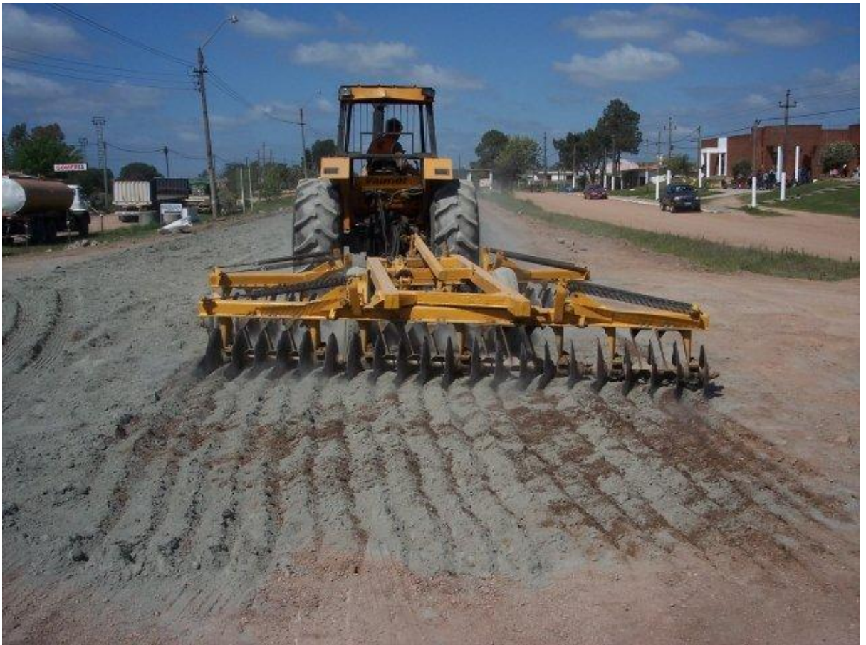
Figura 6.8: Imagen ilustrativa de ejecución de suelo cemento ( https://4.bp.blogspot.com/-1M-AjkaPIMQ/Vpex3ZOozvI/AAAAAAAAARqM/zX7VecjRtGI/s1600/Estabilizacion%2Bde%2Bsubrasante%2Bsuelo%2Bcemento.jpg ).
