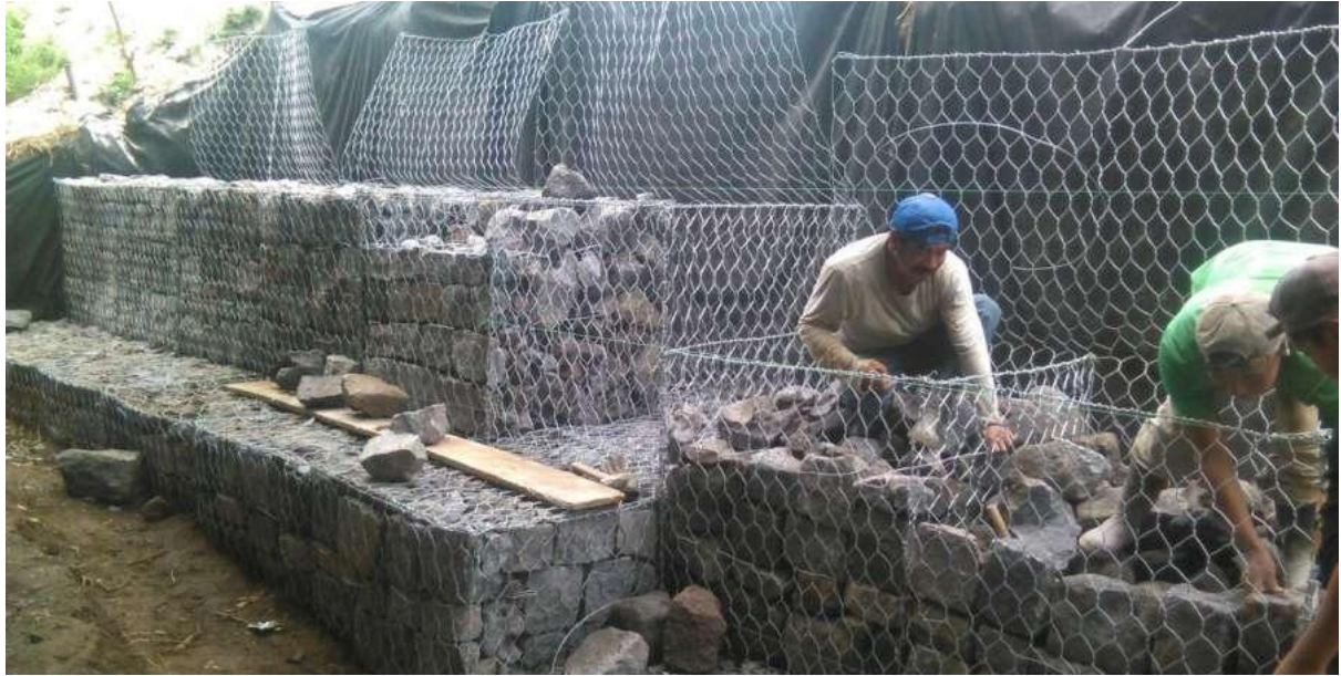
Figura 6.12: Imagen ilustrativa de llenado de gaviones ( https://www.ingecivil.net/2018/01/12/obras-de-gaviones-correcta-ejecucion/ ).
