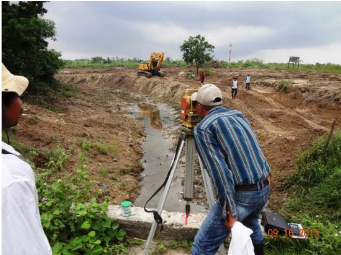
Figura 6.5: relevamiento planialtimétrico mediante el uso de estación total ( https://administracionmalambo.wordpress.com/2013/09/16/con-trabajos-de-trazado-y-replanteo-se-inicio-canalizacion-del-arroyo-el-sapo-en-malambo/ ).
